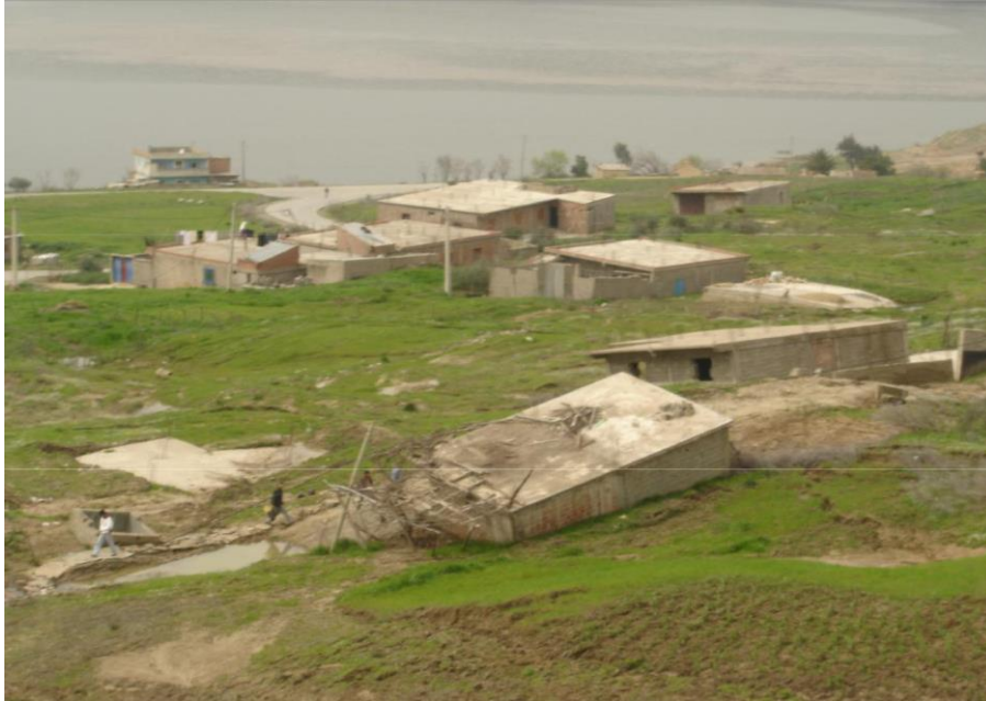
Figure 18 :Glissements de terrains aux abords du barrage de Beni –Haroun (village de Sibari, 2005)
