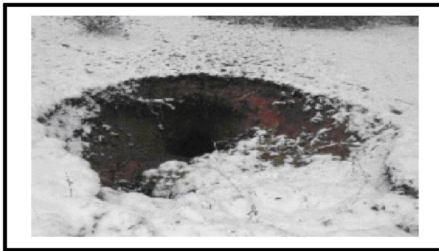
Fig. 17 : Effondrement d'une zone sous-cavée par suffusion © BRGM
