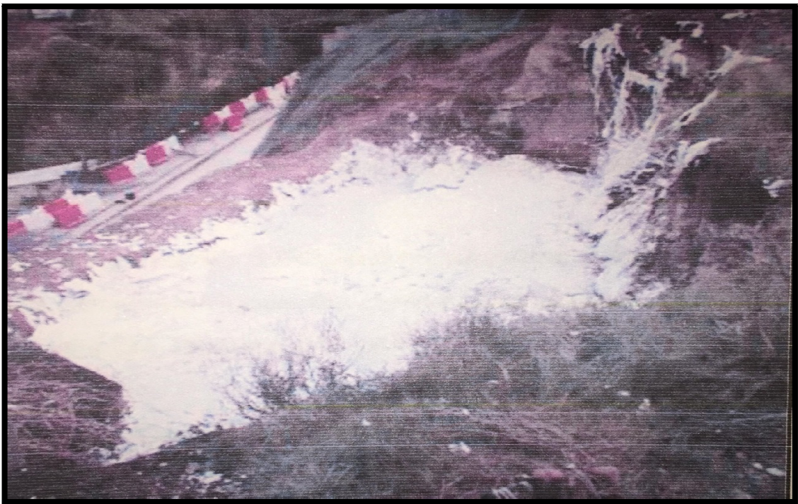
Fig. 62 a : Remplissage d'un fontis par de la mousse thermodurcissable
