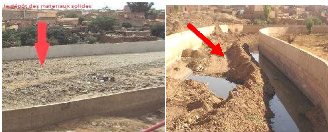
Fig. 41 :L'entretien de lit du oued et le déliage des sédiments.
