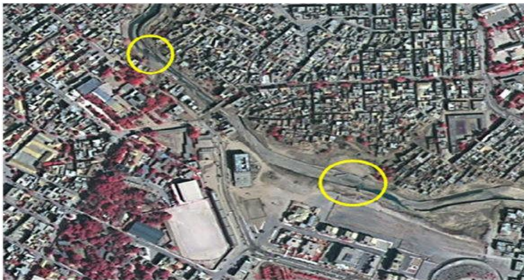
Fig. 40 : Impacts de l'inondation identifiés sur les images du satellite Kompsat (© KARI), matérialisés par la destruction de deux passerelles (cercle en jaune).
