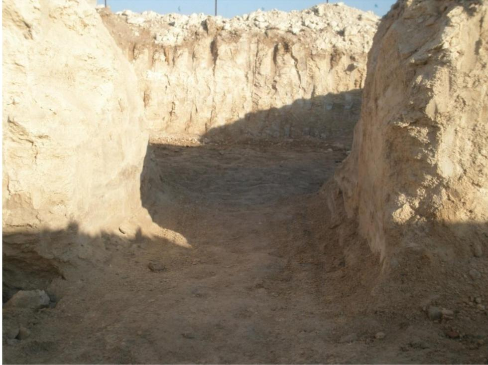
*Fig n°21 : Tranchée dans le site montrant son assise représentée par les limons marno-gypseux.*
