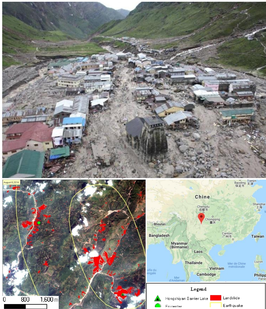
Fig. 10 : Glissement causé par le séisme de Yunnan en Chine (TIAN et al., 2017).
