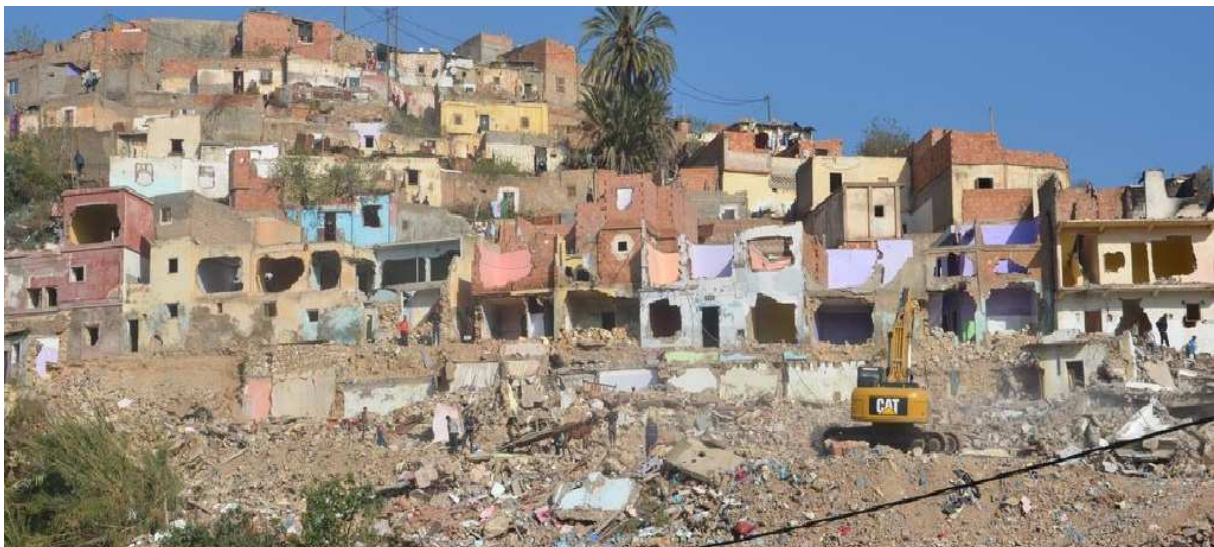
Photo 2 : Les opérations de démolition au niveau de site de Ras el Ain (source : OPGI 2017)
