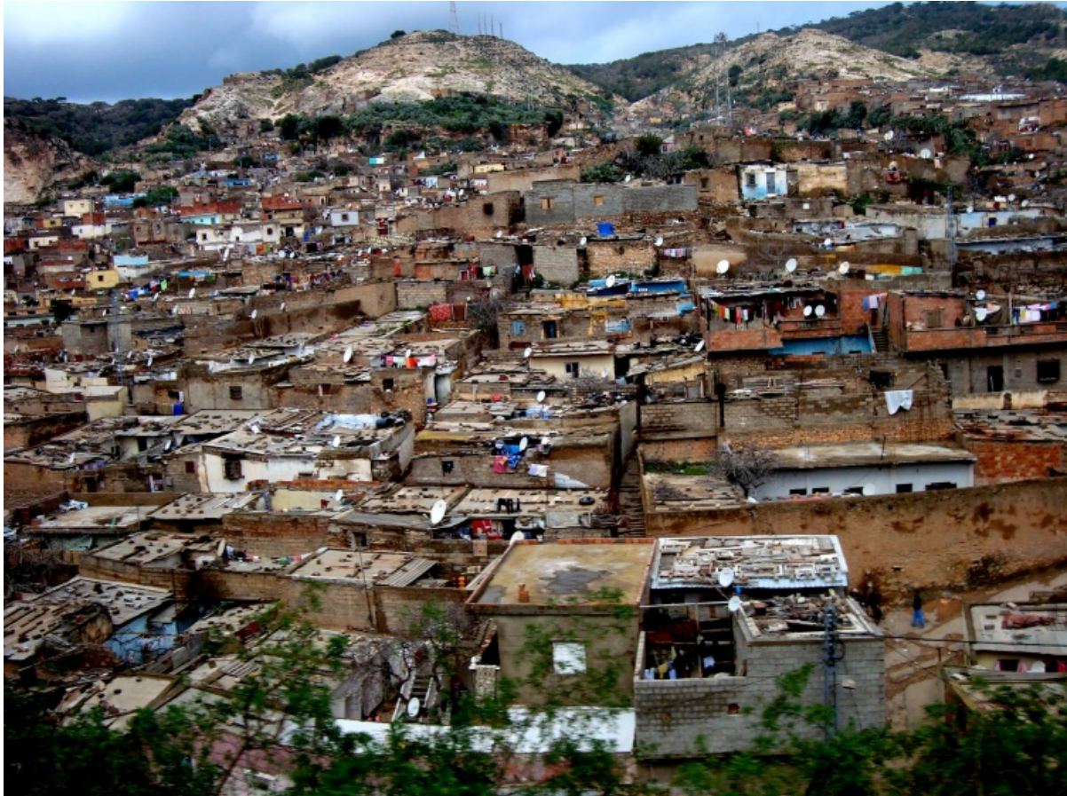
Photo 1 : L'habitat précaire à Rais el Ain avant la démolition (source : OPGI 2017)
