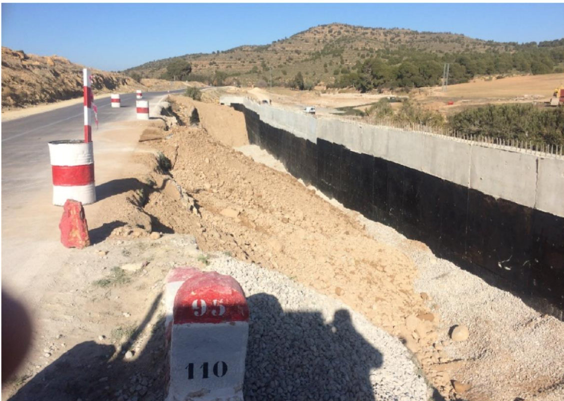
Figure II.2 : Le début de l'achèvement du mur de soutènement
