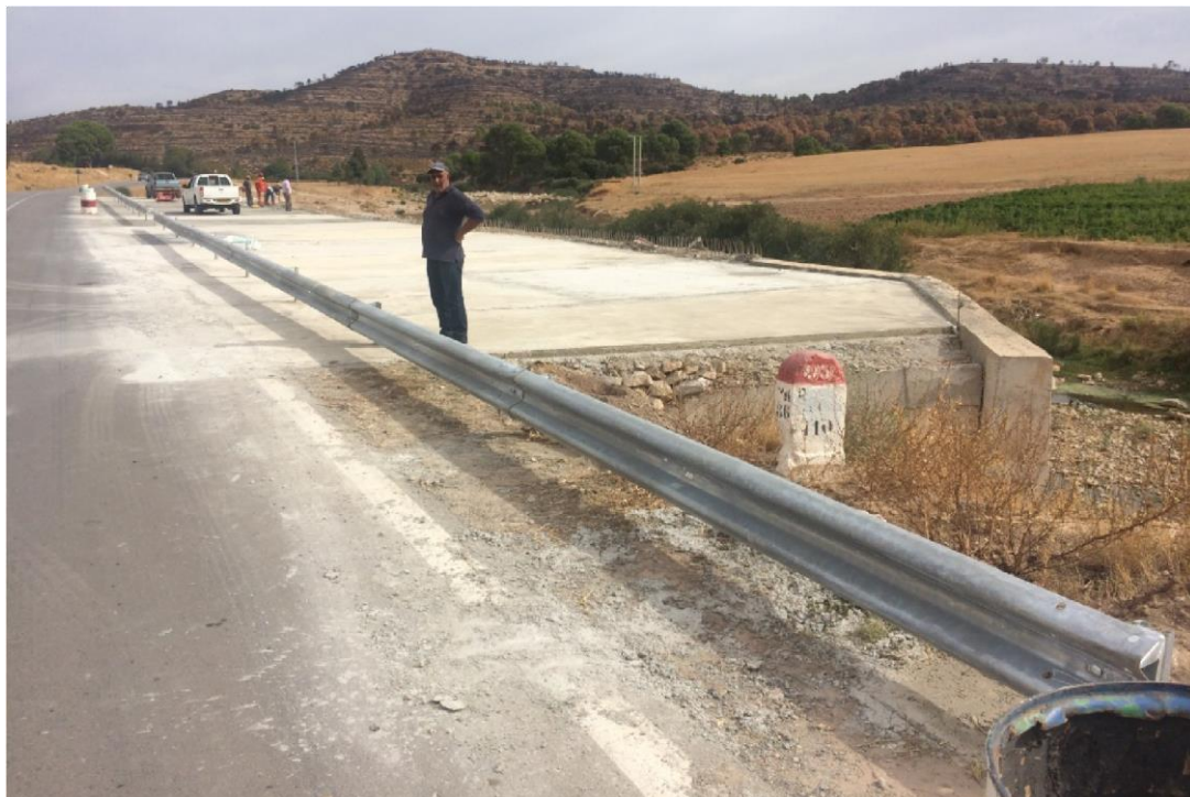
Figure II.3 : Fin de la réalisation du mur
