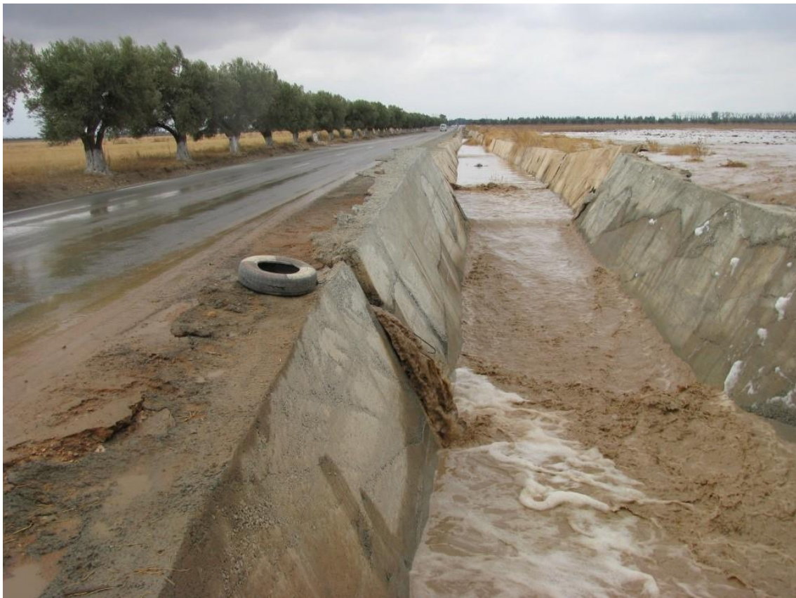
Figure II.5 : Débordement de l'oued sur le canal
