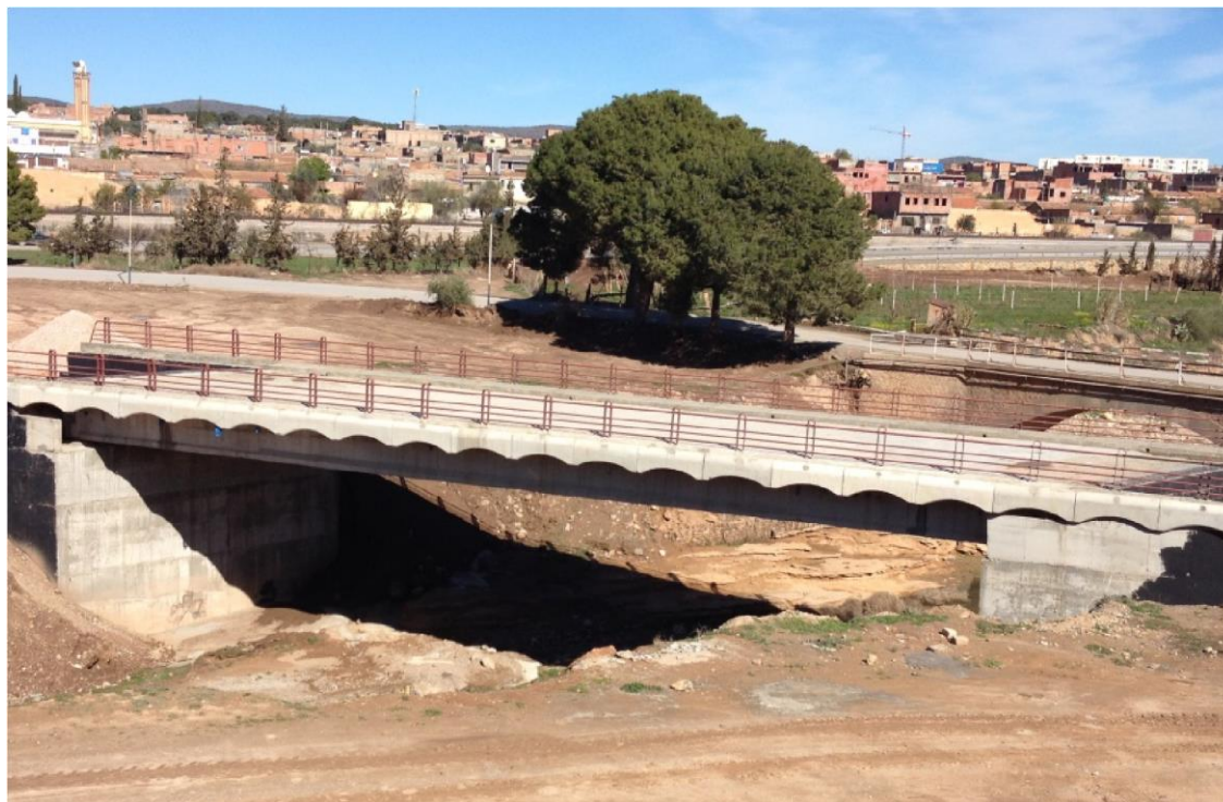
Figure II.1 : Ouvrage d'art de Moulay Slissen
