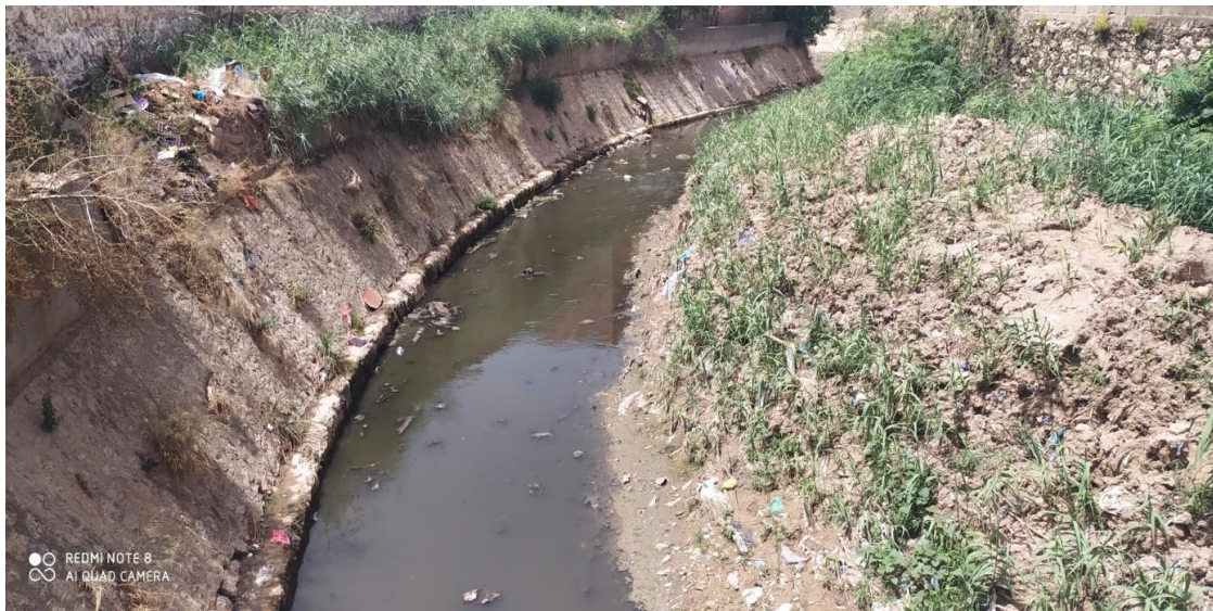
Figure 54: Photo les déchets solides laisser sur les bords après le curage de l'oued 2021
