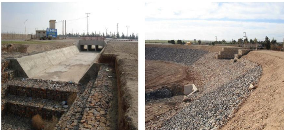
Figure 39: un ouvrage de rétention sur L'OUED MALEH situé à la périphérie Est de la ville SBA
