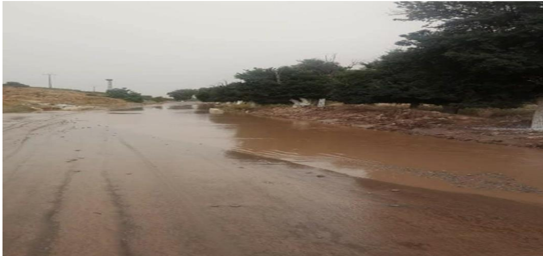
Figure 51: Débordement de la route locale le 14 juin 2021.
