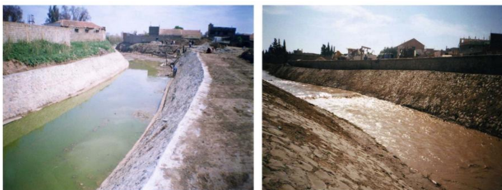
Figure 42: canal évacuateur d'eau au centre-ville
