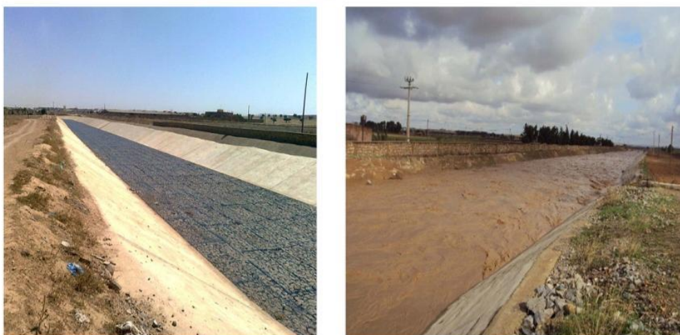
Figure 40: un canal bétonné de 13 Km au Sud de la ville de SIDI BEL ABBES
