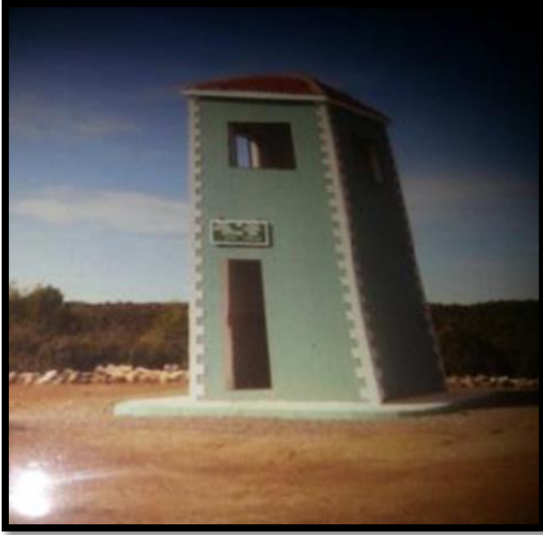
Photo n°07 : installation des postes vigiles, CTF 2019
