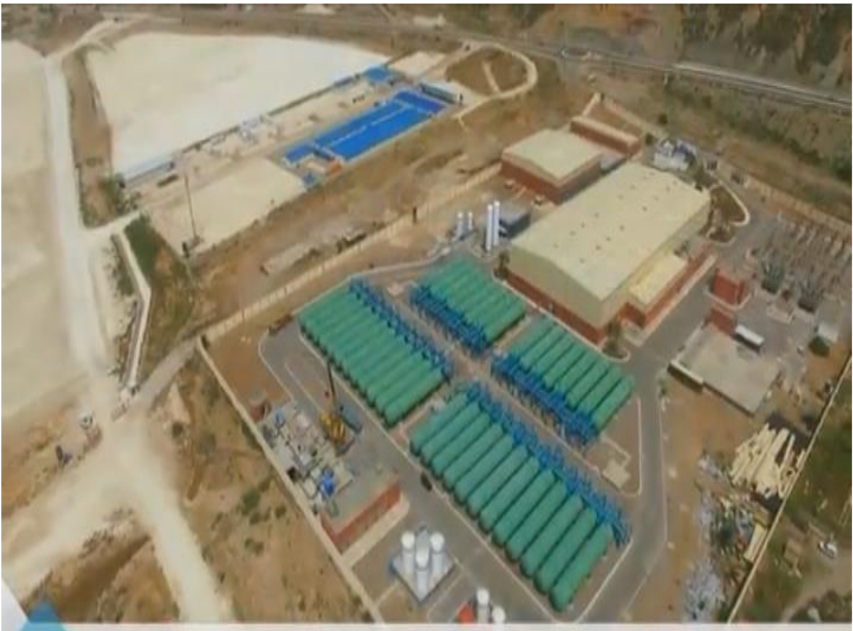
Figure II. 4: Vue générale sur la station de Mostaganem
