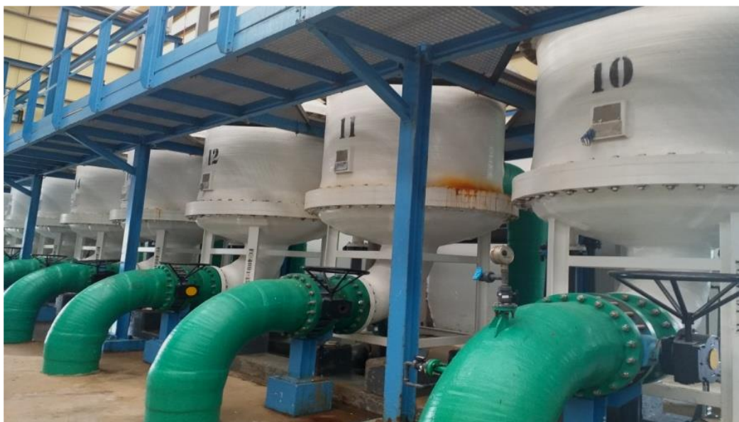
Figure II. 8: Filtres à cartouches
