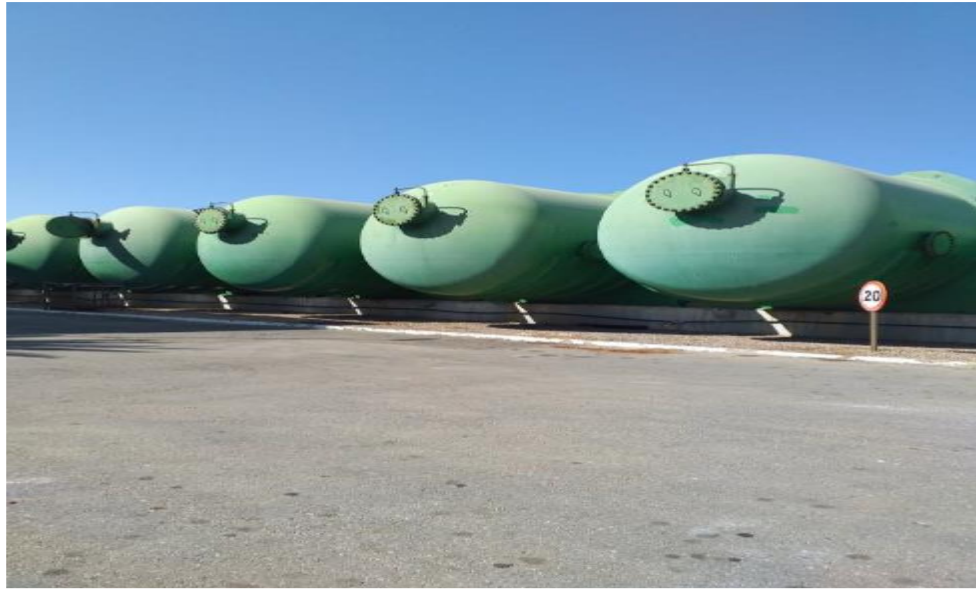
Figure II. 7: Sous système de filtration
