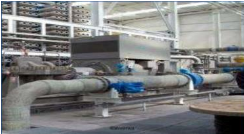
Figure II. 9: Pompe à haute pression
