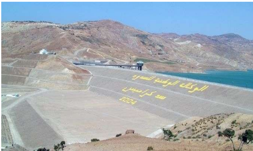
Figure n°10: Talus amont et Aval de la digue du barrage de Kramis.
