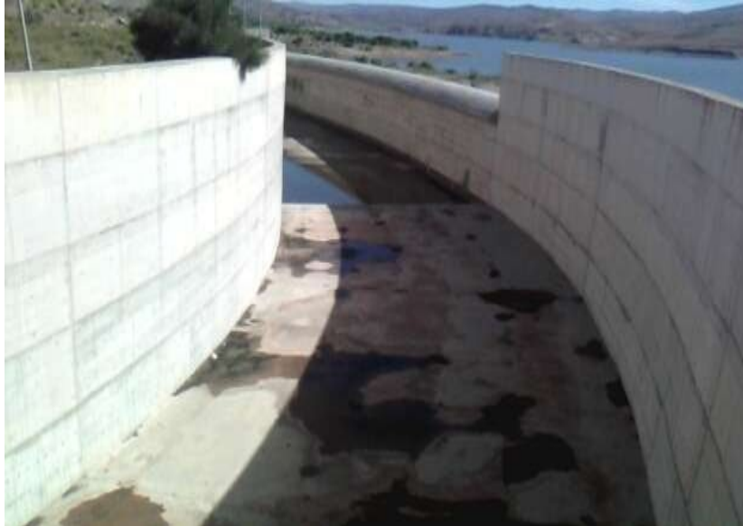
Figure n°11: Evacuateur de crue du barrage de kramis.
