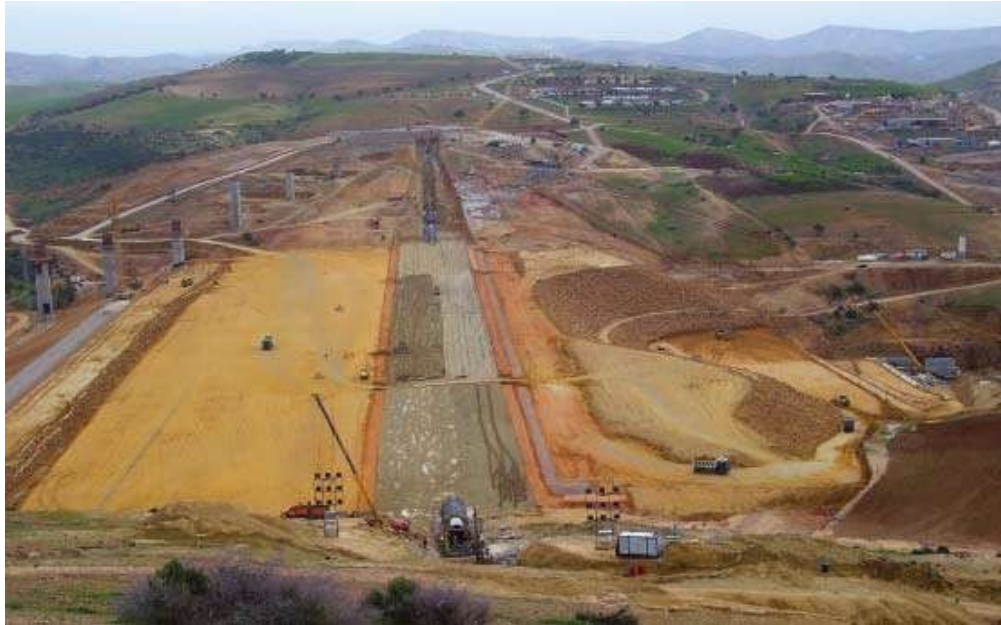
Figure n°9: Barrage de kramis en voie de réalisation (noyau en argile ).
