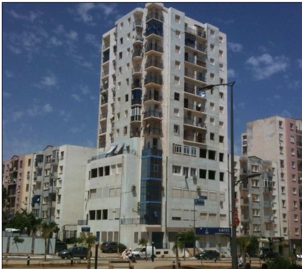
Photo N° 05 : Habitat collectif réalisé
