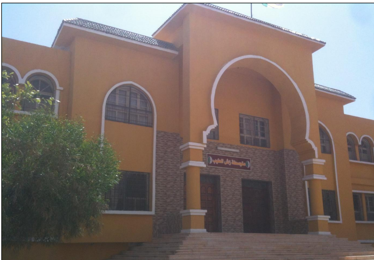
Photo N° 10 : CEM au niveau de la zone d'étude
