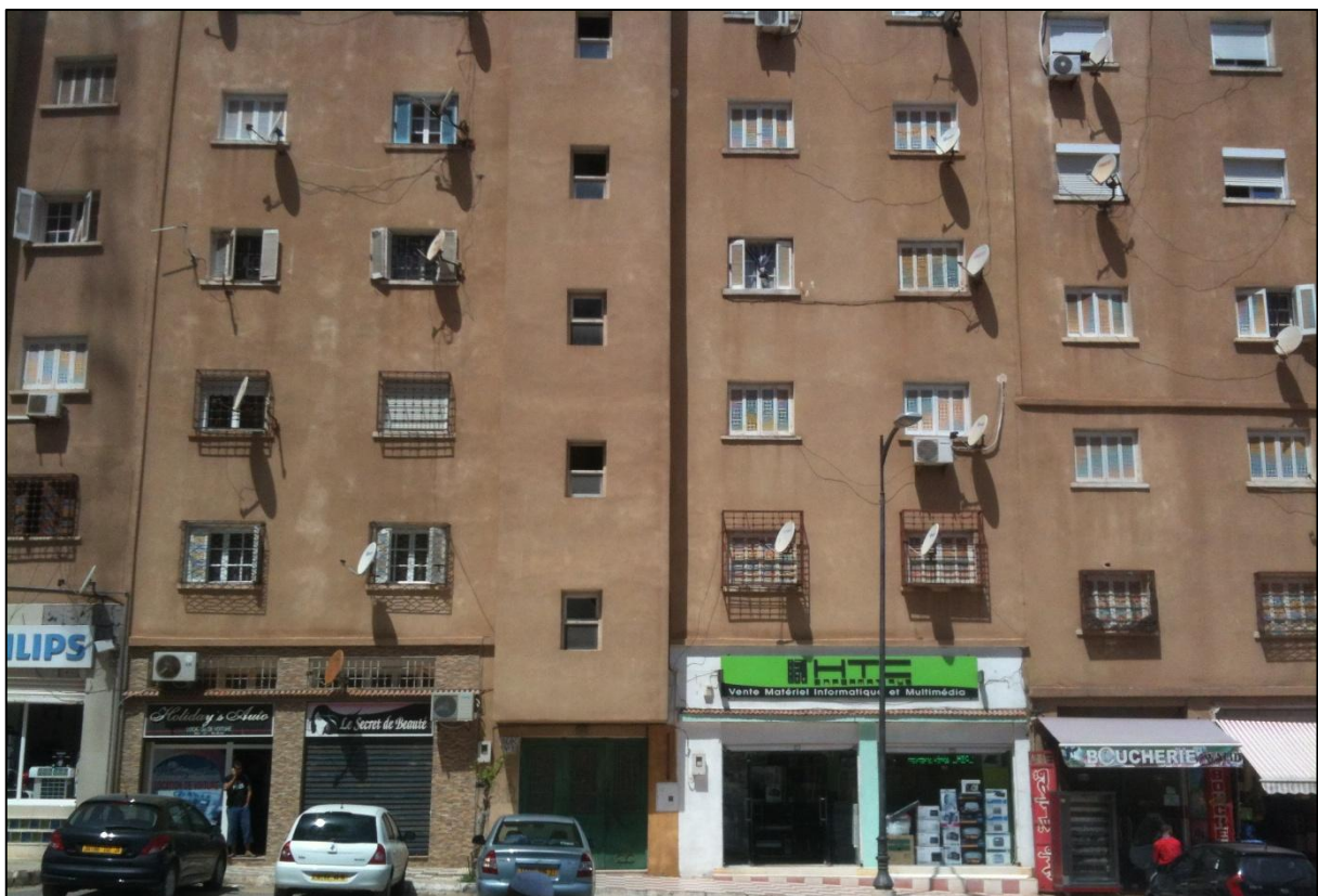
Photo N° 17 : Le commerce au rez-de-chaussée des habitats collectifs
