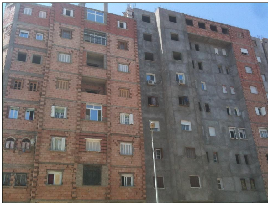
Photo N° 27 : Le projet de 316 logements un quartier sans finition externe
