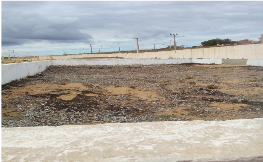
Figure 11 : Lit de séchage
