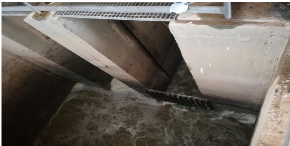
Figure 7 : Dégrillage figure
