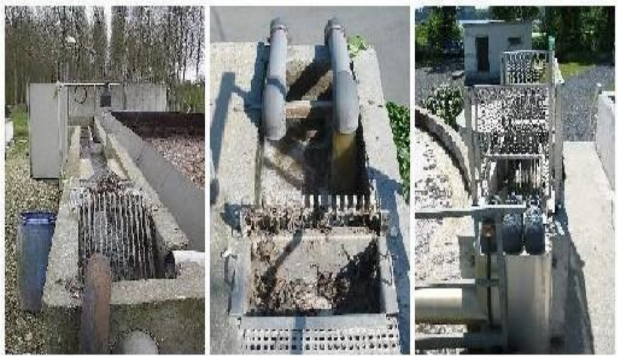
Figure 1:Le dégrillage
