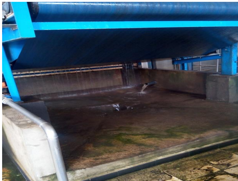
Figure 10 : Filtre à bande
