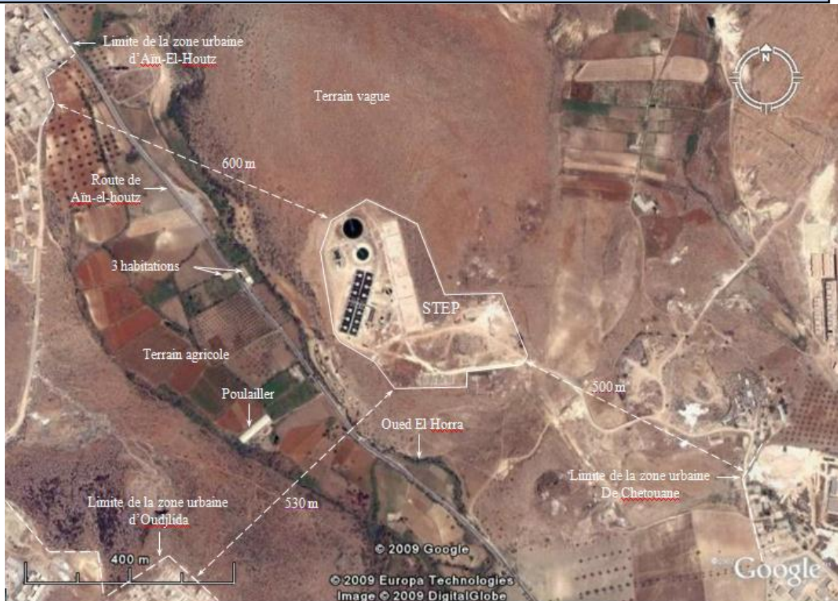
Figure 5 : Photo Satellite descriptive du voisinage de la STEP de Tlemcen
