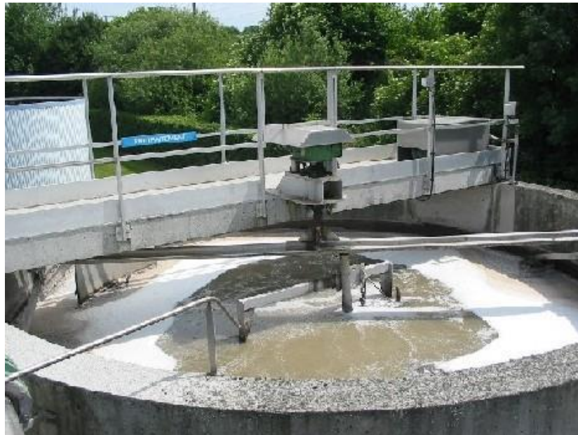
Figure 3: décanteur primaire
