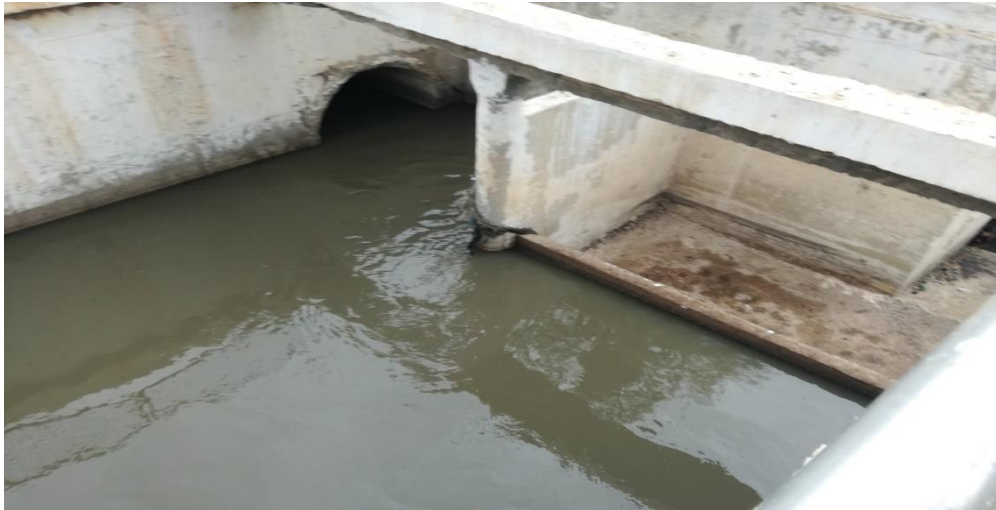
Figure 6 : Déversoir d'orage
