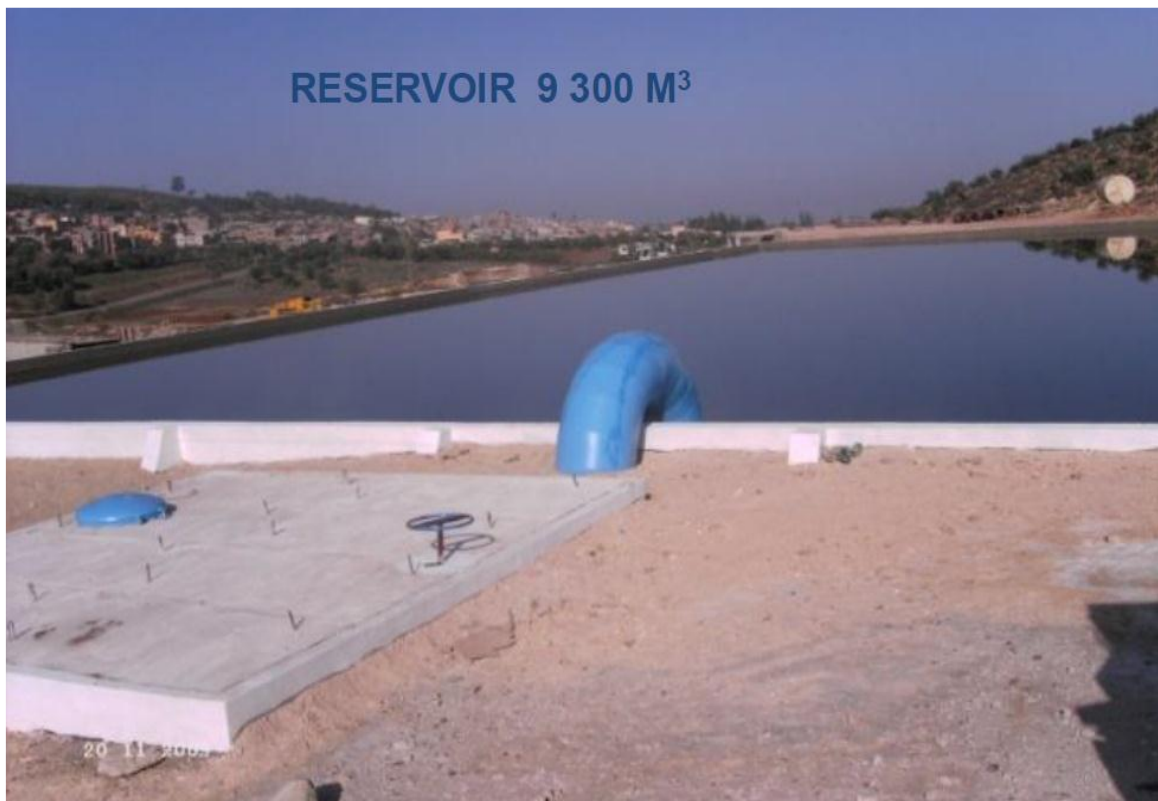
Figure 22 : réservoir de stockage
