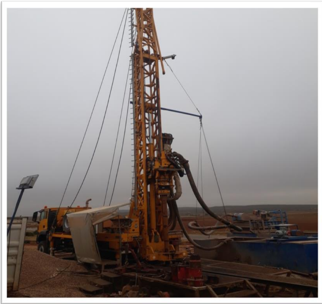
Figure 14 : L'appareil de forage rotary sur le chantier
