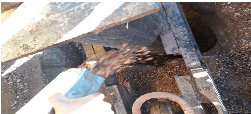
Figure 28 : Mise en place du gravier additionnel
