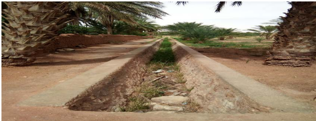
Figure 39: Drain secondaire qui se divise dans le drain principale
