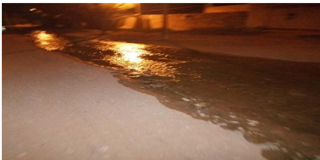
Figure 29: Débordement des eaux usées après bouchage du réseau d'assainissement
