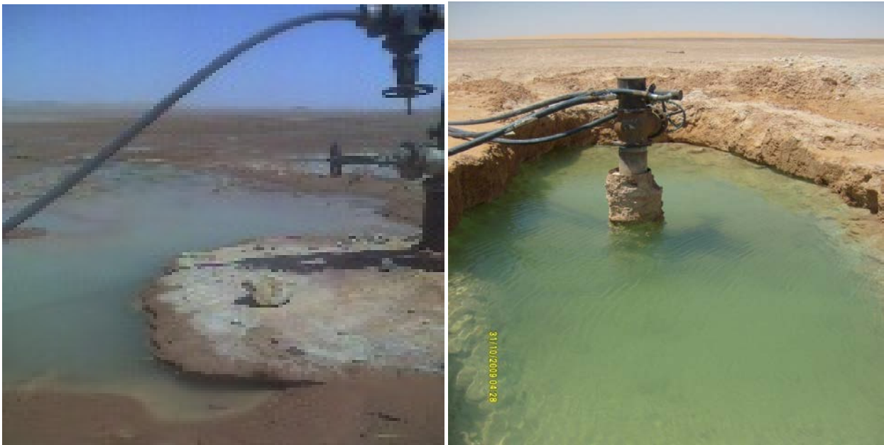
Figure 33: Eruption et fuites d'un forage albien réalisé par battage avec une mauvaise cimentation .
