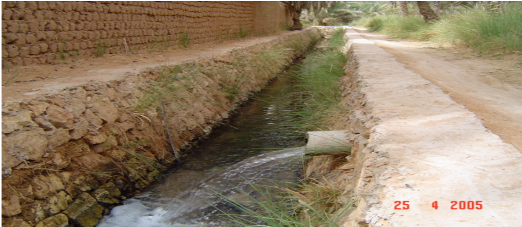
Figure 38: Drain principale (collecteur principale)
