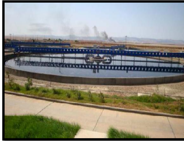
Photo. n°10 : Le décanteur secondaire (clarificateur).
