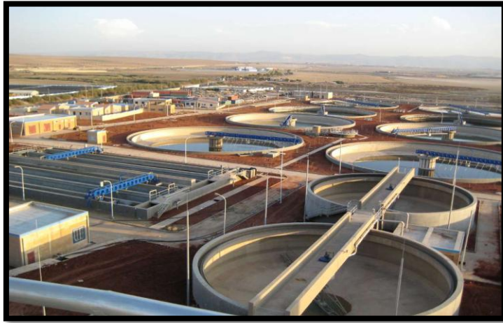
Photo. n°6 : Station d'épuration d'El Kerma
