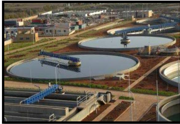
Photo. n°9 : Décanteur primaire
