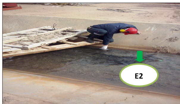
Fig. 2.3 : Canal de rejet des eaux huileuses (Site E2).
