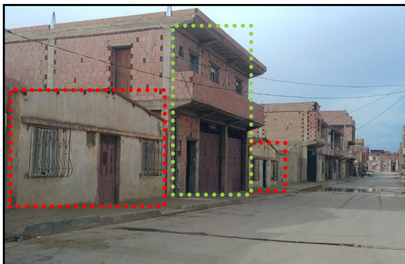
Figure n°57 : Mutation, remodelage et extension de la maison rurale de l'ex village agricole socialiste à Douar-Djdid (ce dernier a constitué le noyau de l'extension de toute l'agglomération à partir des années 1990)
