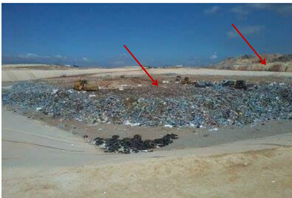
Saturation des casiers d'enfouissement du CET Hassi bounif (2017)
