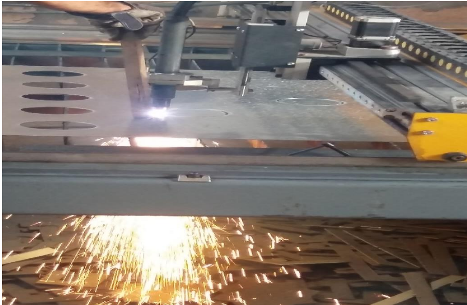
Figure 18 : Réalisation du crible de la table A à l'aide d'une tronçonneuse plasma
