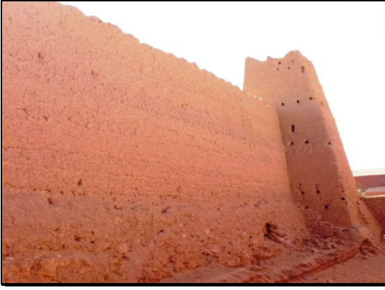
الصورة رقم (6): السور الغربي وبرج القصبة. تليلولين 2014
