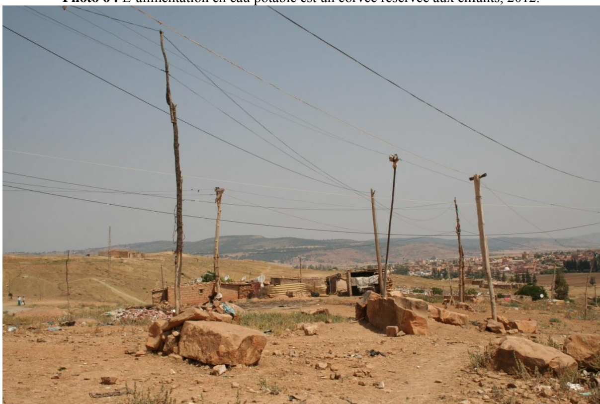
Photo 7 : le câblage illicite pour l'acquisition du courant électrique à Dhar Chih , 2013.
