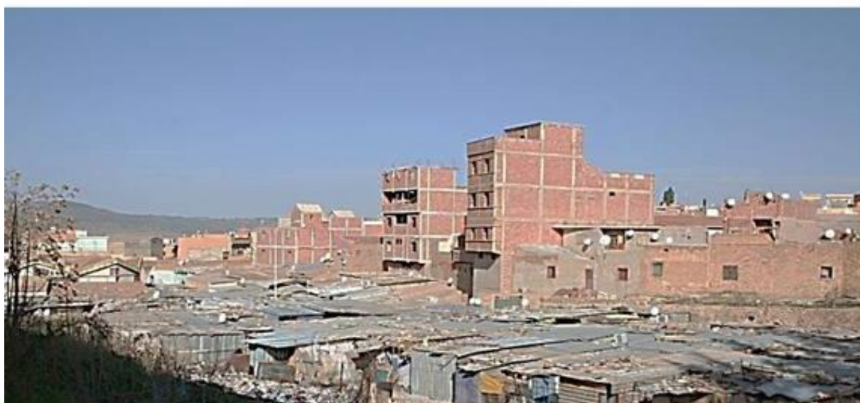
Photo 12 : un bâti en attente d'achèvement, 2013.
