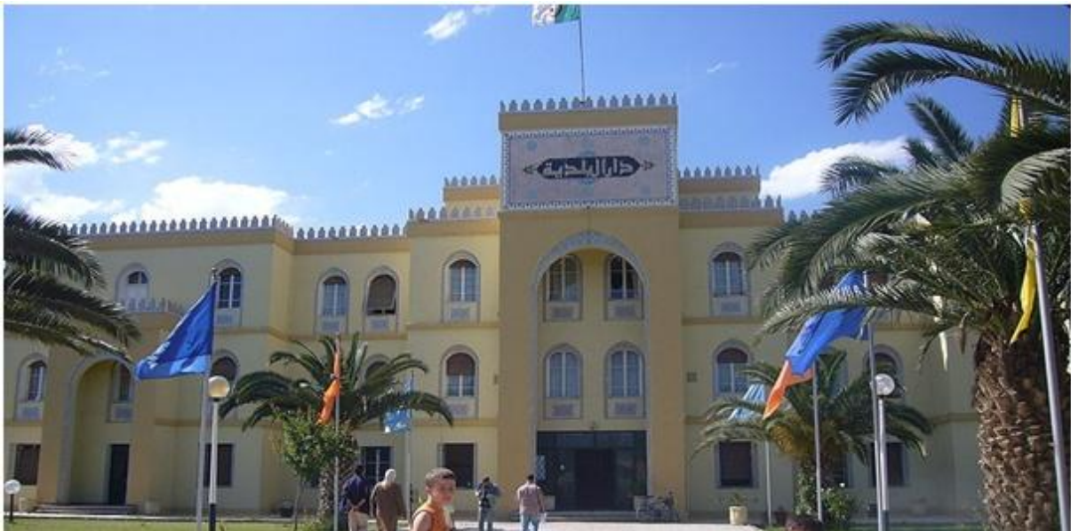
Photo n°5 : le siège de l'APC de Tlemcen délocalisé du centre ville
