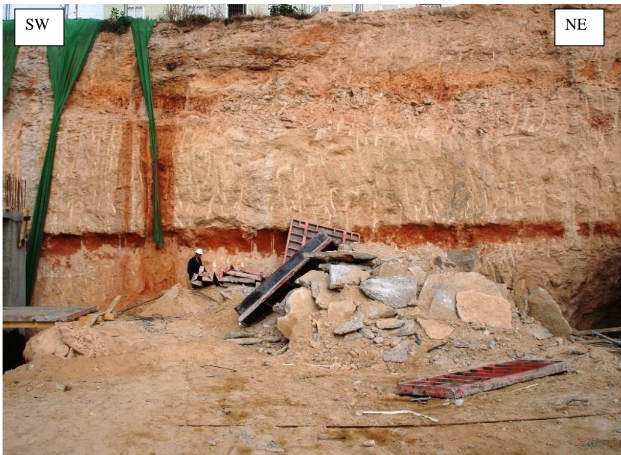
Fig.59: Le massif dunaire pléistocène moyen et supérieur ( ?) séparé en deux fois par le sol rouge (Bahia Center)
