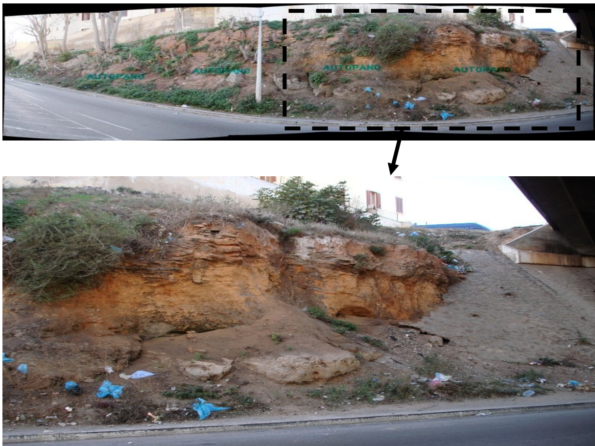
Fig.51: affleurement d'un banc de grès dur au niveau du Pont de la route du Port (culée ouest)
