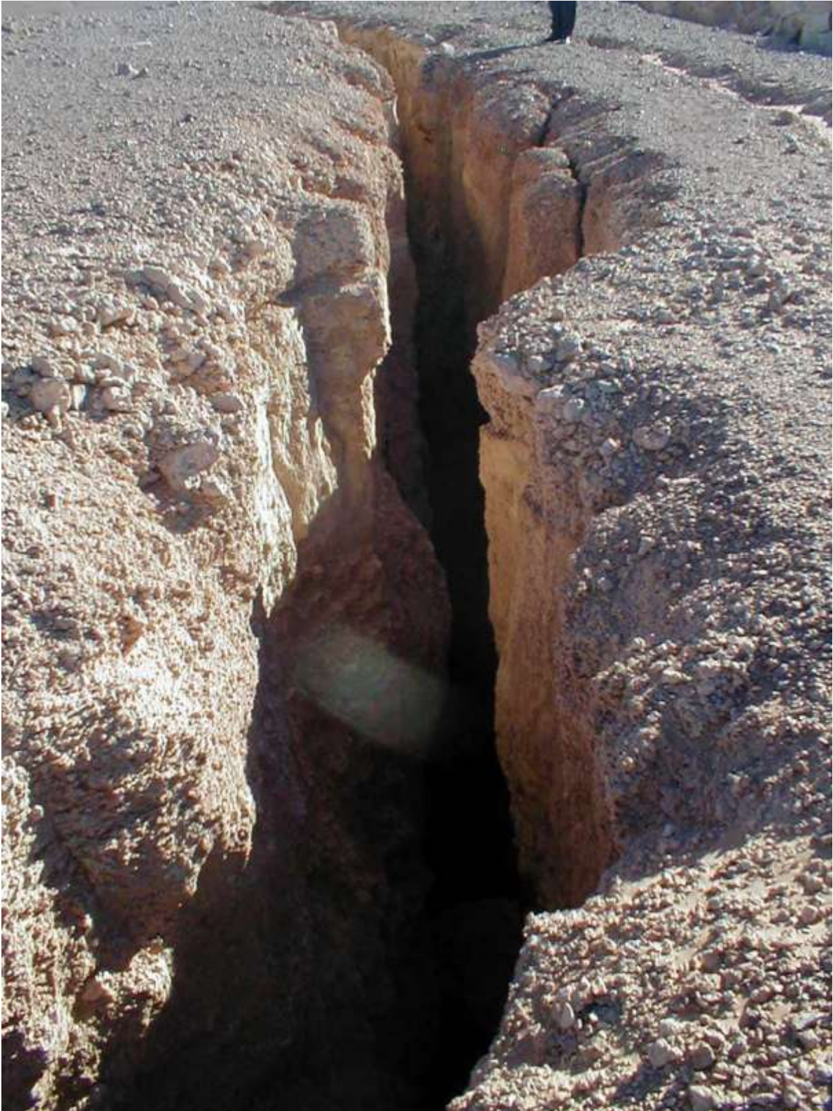
Fig.9 : Fissures en surface du puits OKN 32
