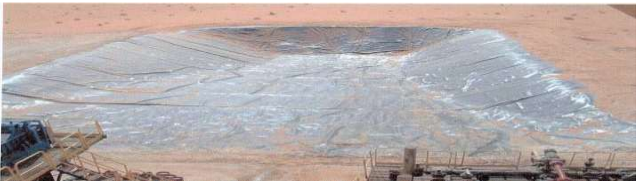
Photo N°6 : Imperméabilisation du bourbier
