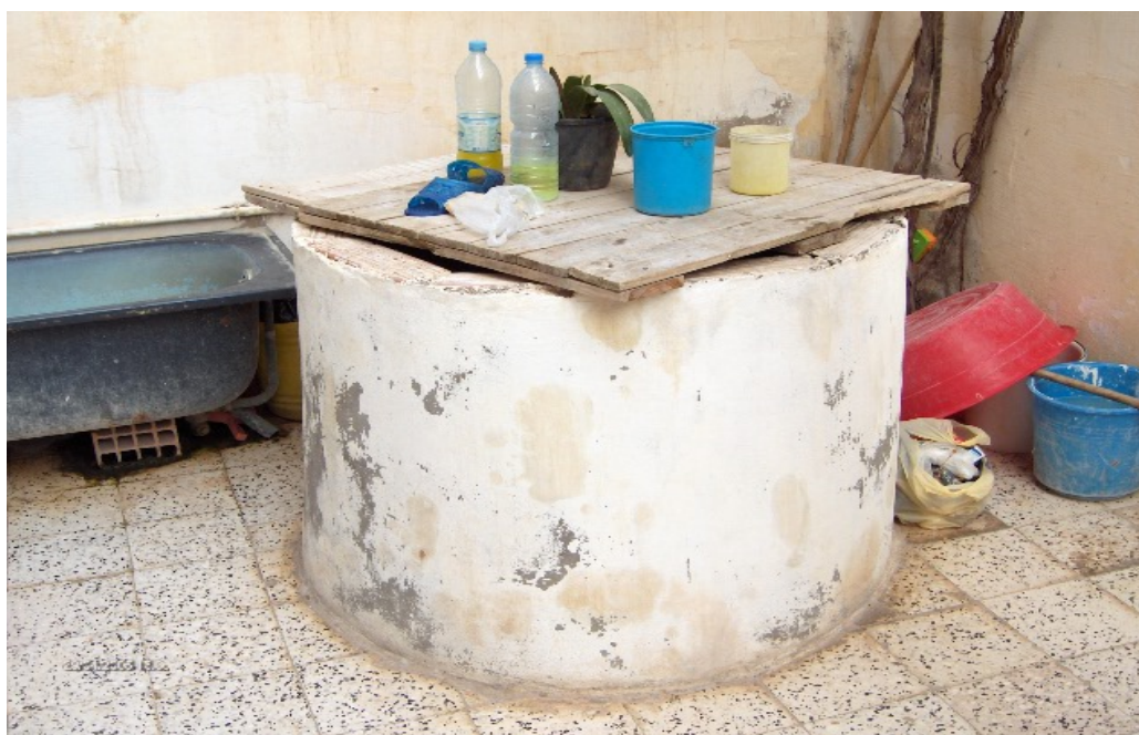
Photo N° 10 : Puits a l'intérieur d'une maison, El Kerma en 2004.
