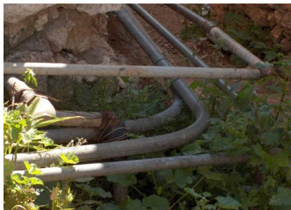
Photos N° 4 : micro réseaux d'AEP autonome à la surface du sol du Douar Habib Bouakeul en 2005
