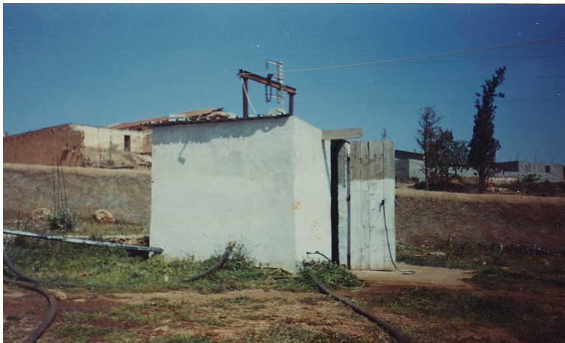
Photo N° 12 : Point de vente de l'eau à Bouamama dans une exploitation agricole en l'an 2001.
