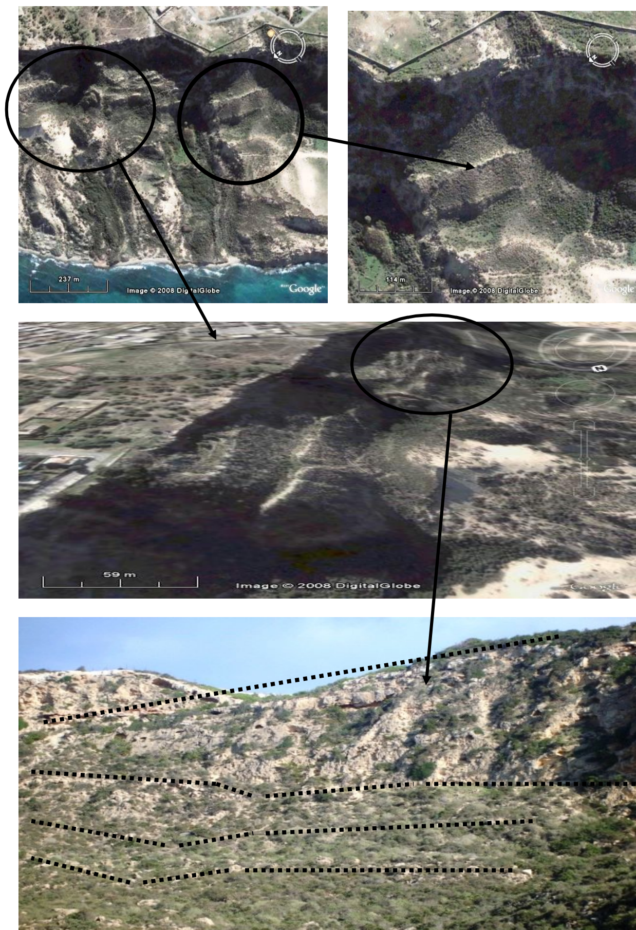
Fig.183: Rides d'extension plurimétriques au contrebas de Canastel
