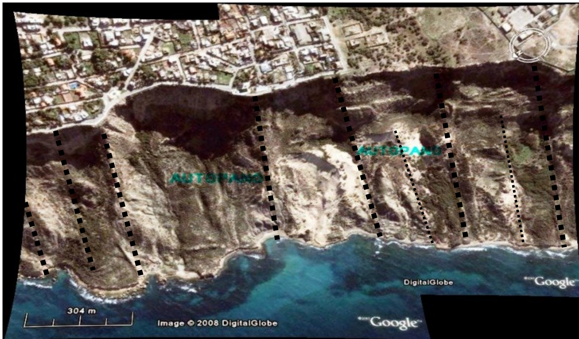
Fig. 226: Failles hypothétiques déduites de l'analyse de la forme des masses glissées (Au contrebas de Canastel) Trait noir : failles subverticales N90° à 100°E
