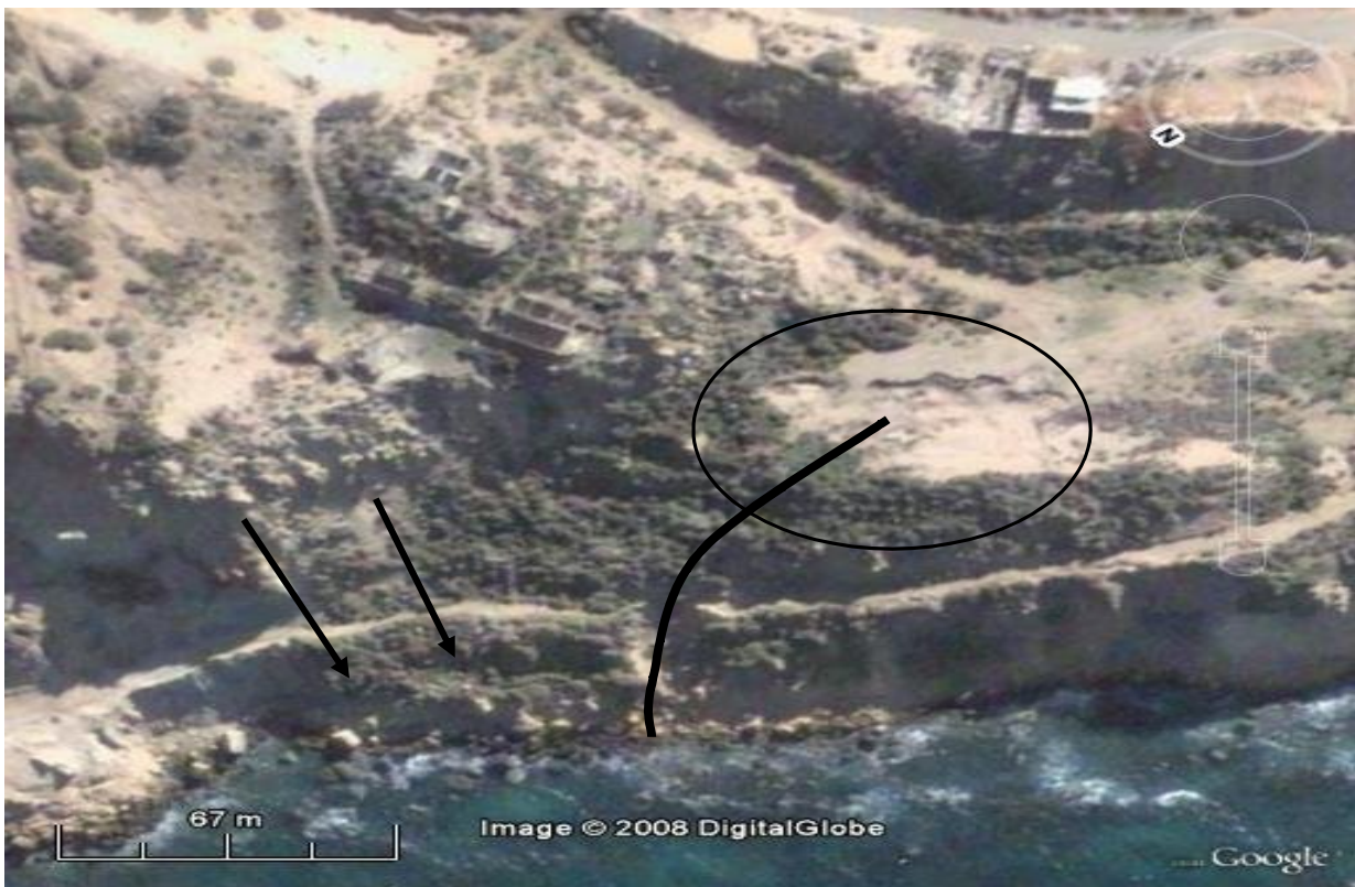
Fig.178 : Glissement et chute de blocs (cercle : tributaires à l'amont du glissement, flèche noire:sens du mouvement)
