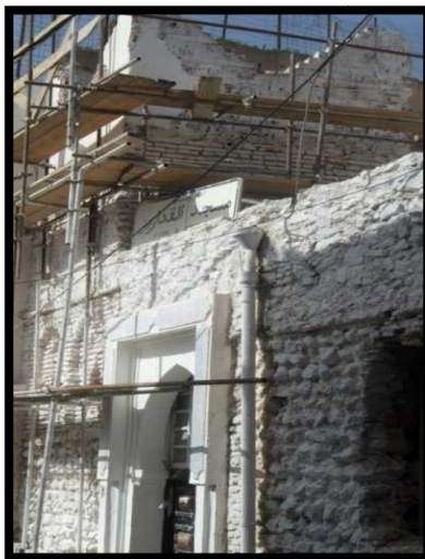
Photo N°17 : la mosquée Queddarine ou Fekharrine en cours de sa restauration
