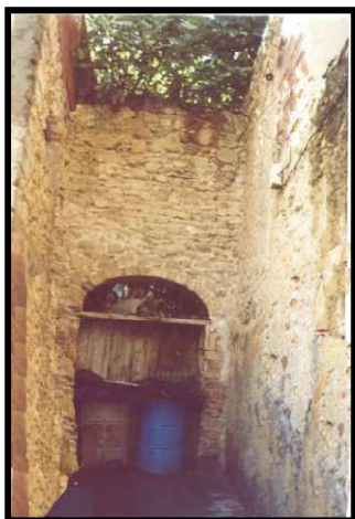
Photos N°32 : L'entrée du fondouk côté ouest de la mosquée de l'El-Ria. 2011. (Source : Auteur)
