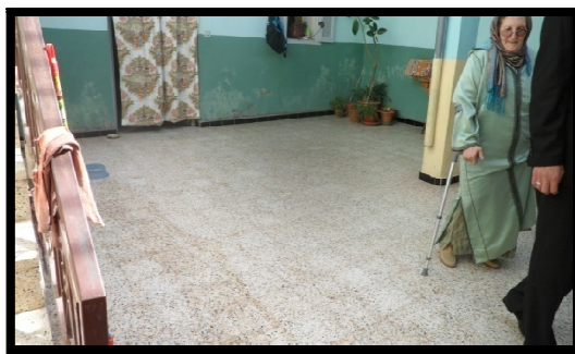
Photos N°68 : changement de wast eddar par élimination du puits et la pose de carrelage de type granito en 2011
