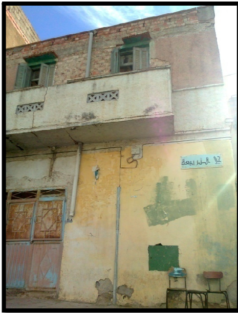
Photo N°52 : Maison coloniale avec balcon en R+1 (ex Place marché de laines). 2011 (Source : Auteur)
