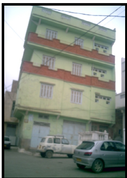
Photo N°54 : Maison moderne avec balcon en R+3 2011 (Source : Auteur)
