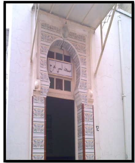
Photo N°16 : Mouçalla de Sidi Laaradj 2011. (Source : Auteur)
