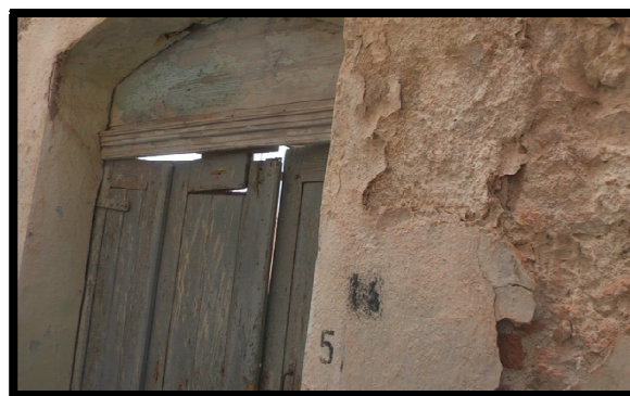
Photo N°55 : la dégradation d'une maison par l'humidité Photo N°56 : la dégradation d'une
