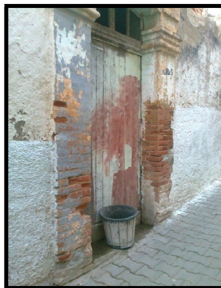
Photo N°58 : la toiture d'une maison traditionnelle Photo N°59 : affaiblissement des matériaux pour les murs 2011 (Source : Auteur).
