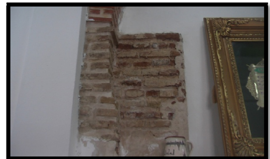
Photo N°14: une partie indiquant les matériaux de construction de la grande mosquée
