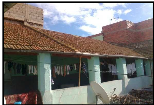
Photos N°31 : la toiture d'Eddar
