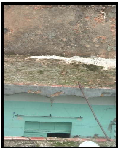
Photo N°55 : la dégradation d'une maison par l'humidité Photo N°56 : la dégradation d'une
