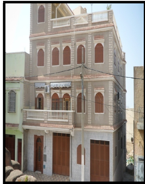
Photo N°53 : Maison moderne avec balcon en R+2 2011 (Source : Auteur)
