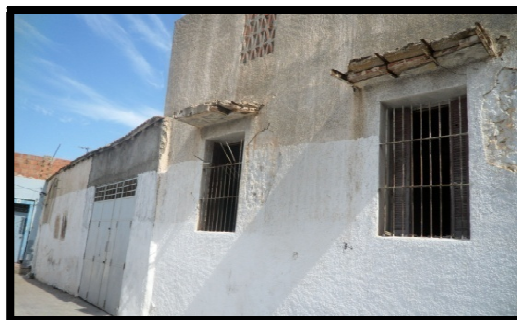
Photos N°65 : les murs décroûtés de leurs enduits et revêtus d'un enduit neuf en mortier de ciments
