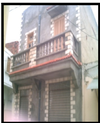
Photos N°66 : la construction avec des matériaux étrangers de la médina 2011
