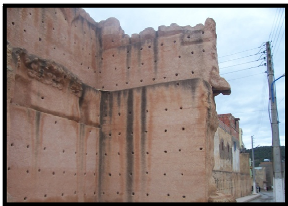
Photo N° 03 : la muraille après sa restauration, 2011
