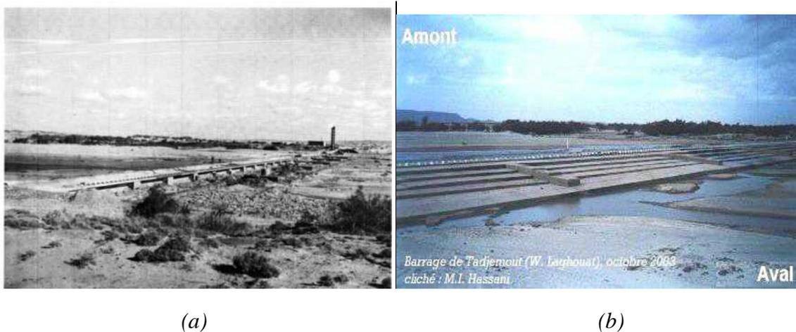
**Figure 33 :** vues générales du premier barrage d'inféro-flux d'Algérie : le barrage de Tadjemout sur l'Oued Mzi (W. de Laghouat)
