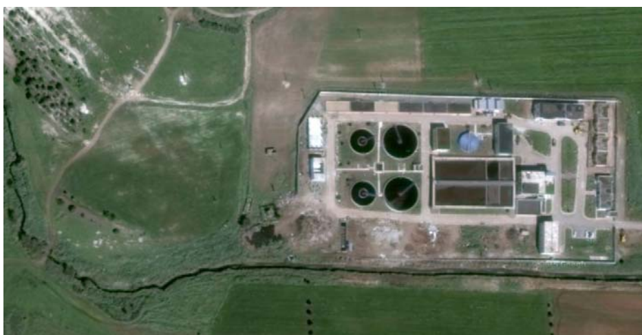
Figure 46. Vue satellitale de la station d'épuration à boues activées d'Ain Témouchent en 2016 (Google Earth, 2016)
