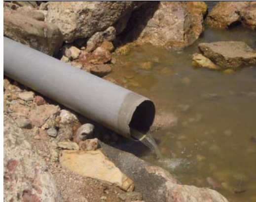
Photo 14. Point de rejet au niveau des Andalous (clichée : TAGHEZOUT, 2014)
