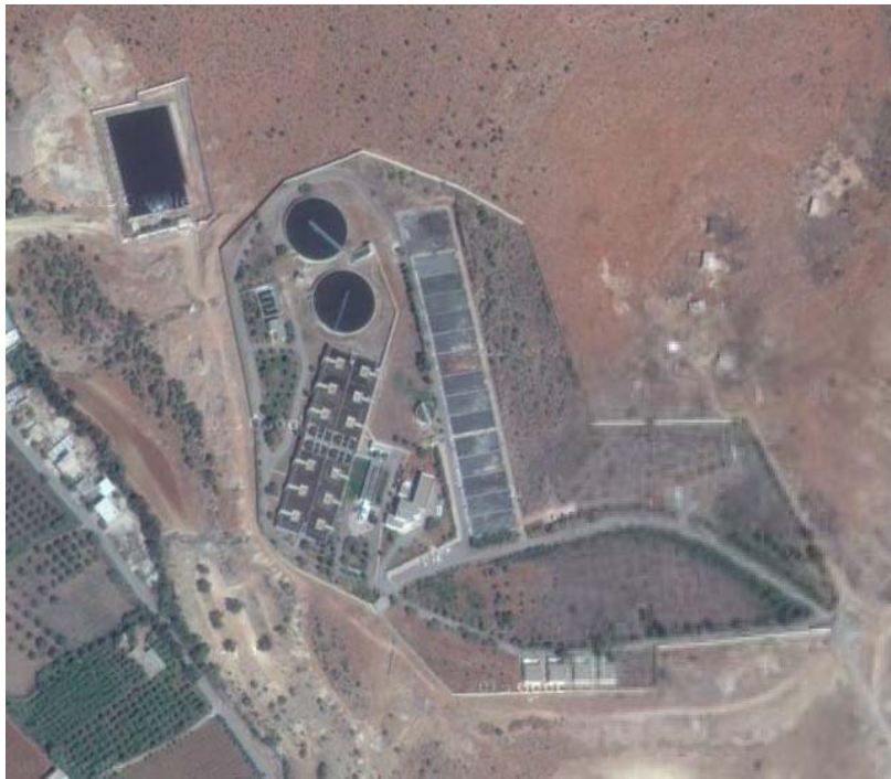
Figure 48. Vue satellitale de la station d'épuration d'Ain El Houtz
