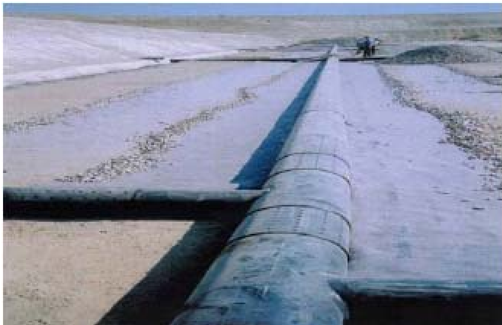
Photo 8. Réseau de drains des lixiviats (Clichée: CET de Tlemcen, 2016)
