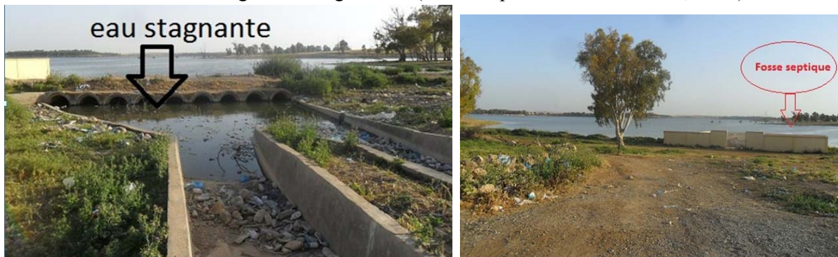
Photo 19. Images montrent les eaux usées stagnantes et une fosse septique en aval creusée à la limite de la berge du barrage Sarno (clichée : photo Bel Abbès info, 2016)
