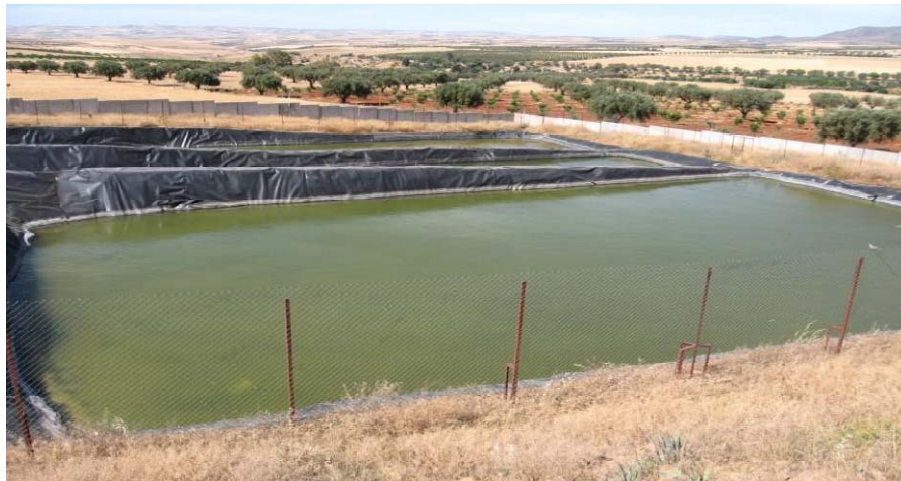
Photo 10. Les bassins de lixiviâts du CET de Tlemcen (Clichée : CET de Tlemcen, 2016)
