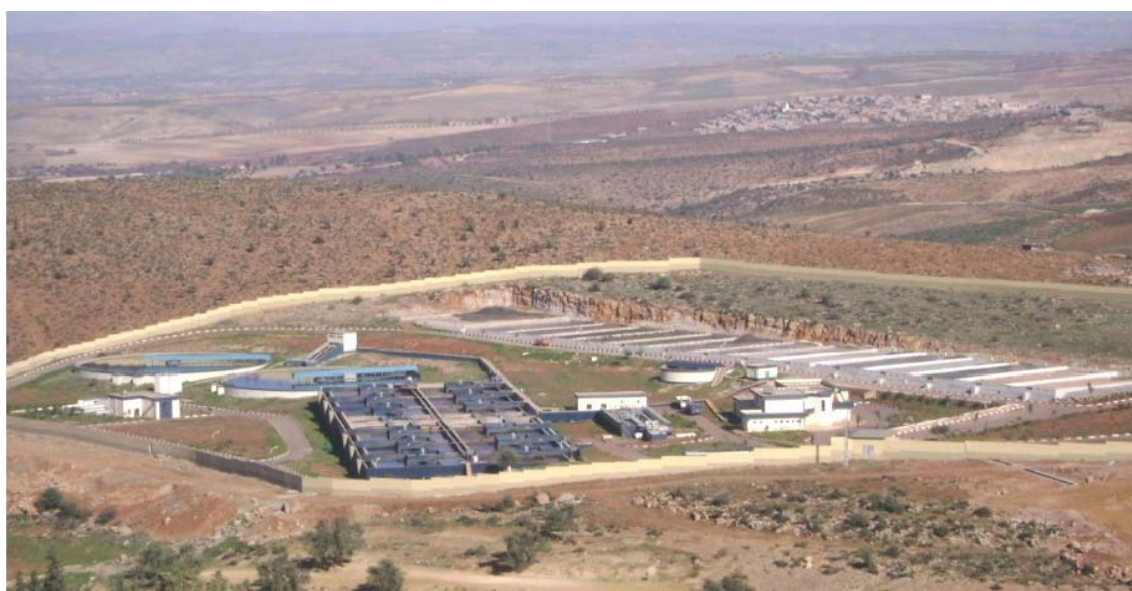
Photo 17. Vue générale de la STEP d'Ain El Houtz (clichée : STEP Tlemcen, 2015)
