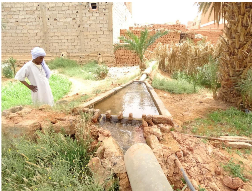
Photo 5 : Répartition de l'eau par kasria (peigne) à ciel ouvert, pour garder le partage visible malgré le remplacement des seguias par des canalisations en béton et en plastique (S.Idda, avril 2017)
