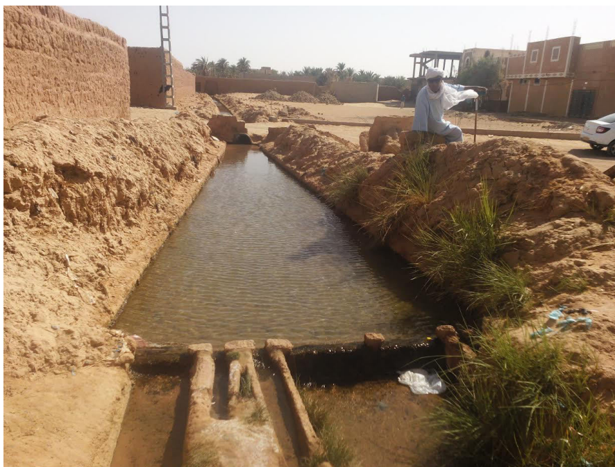
Photo 4 : Kasria ou peigne de distribution de l'eau de la foggara dans l'oasis d'Ouled Brahim (S. Idda, juin 2016).
