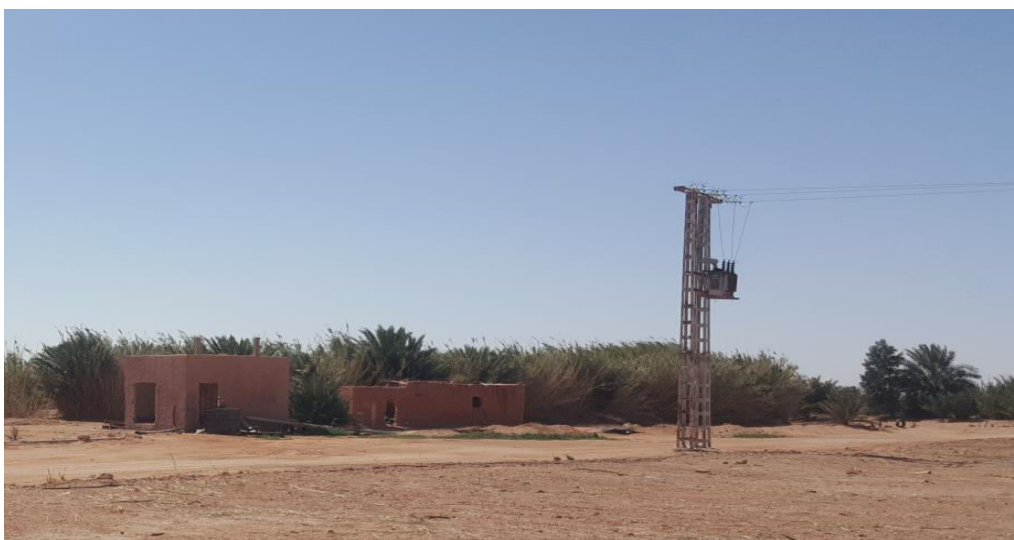
Photo 8 : Forage d'irrigation et transformateur électrique (S.Idda, février 2018).
