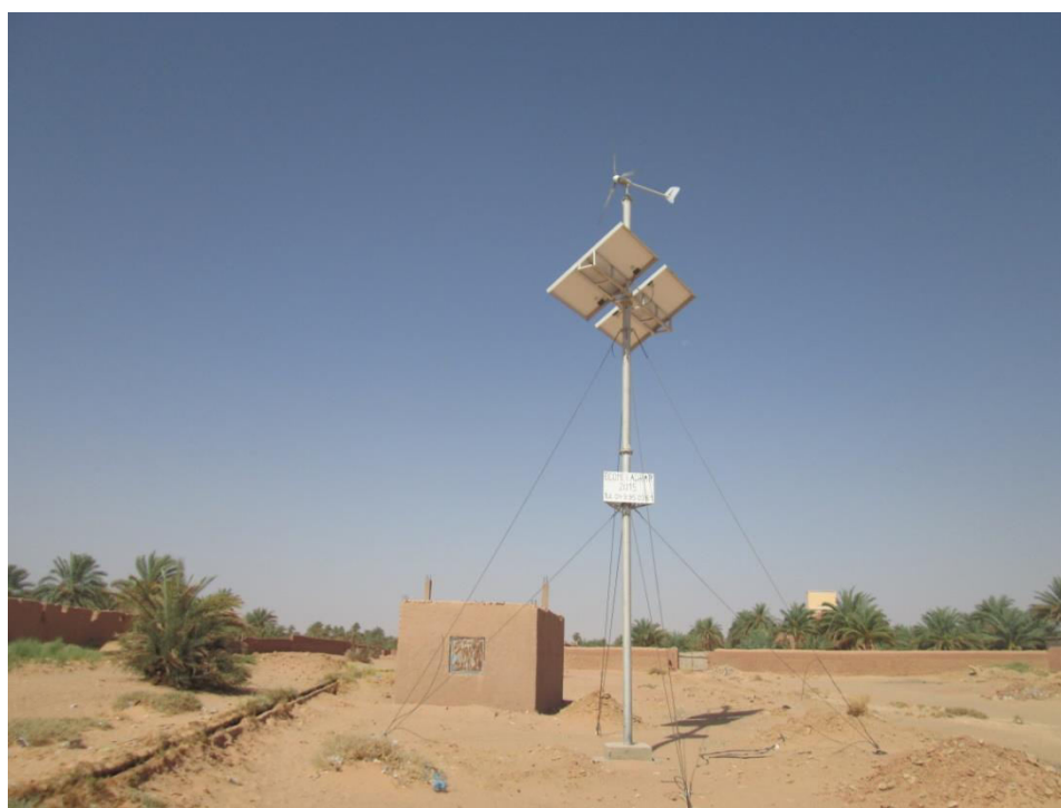
Photo 3 : Un puits doté d'un panneau solaire et d'une éolienne à Fenoughil (S.Idda, février 2018)
