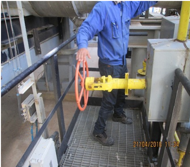
Figure 25.19 une vanne bloquant le passage
