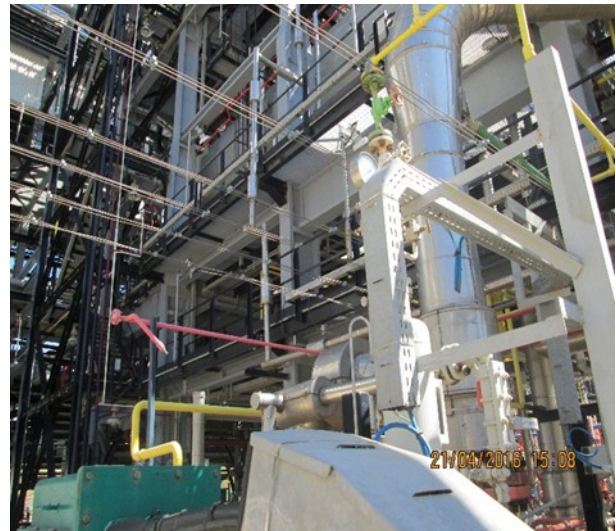
Figure 25.04 un baromètre mal positionné
