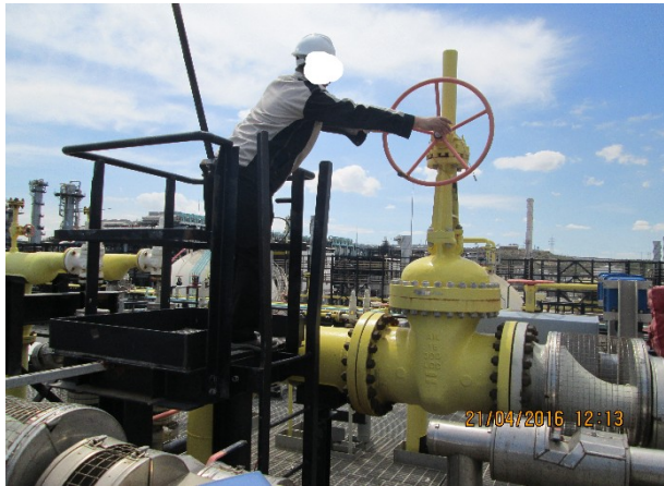
Figure 19 : mauvais emplacement de la plate-forme A
