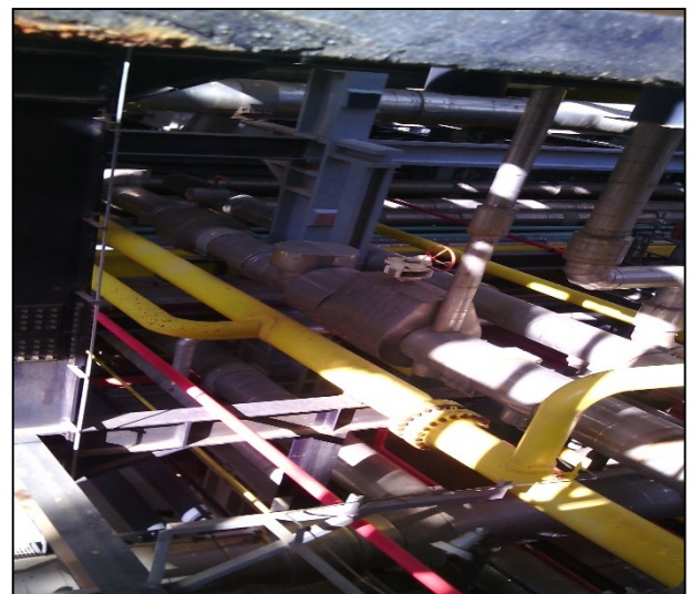
Figure 03 : Vannes inaccessibles
