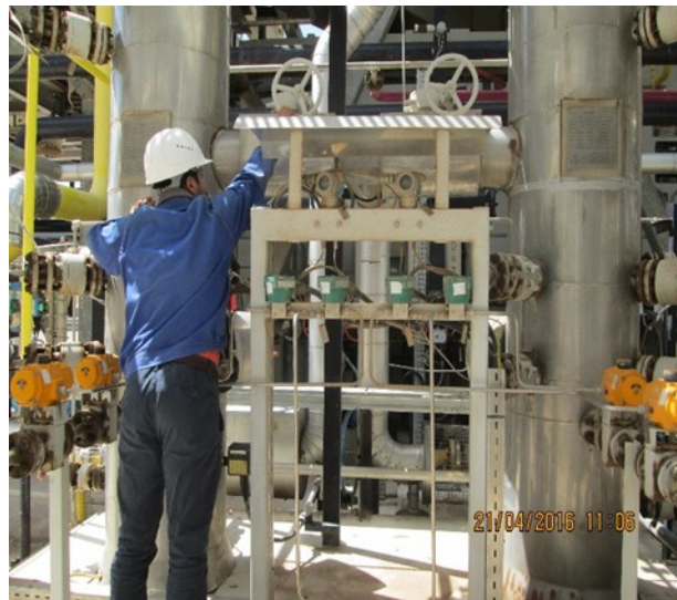
Figure 25.22 une vanne difficilement accessible
