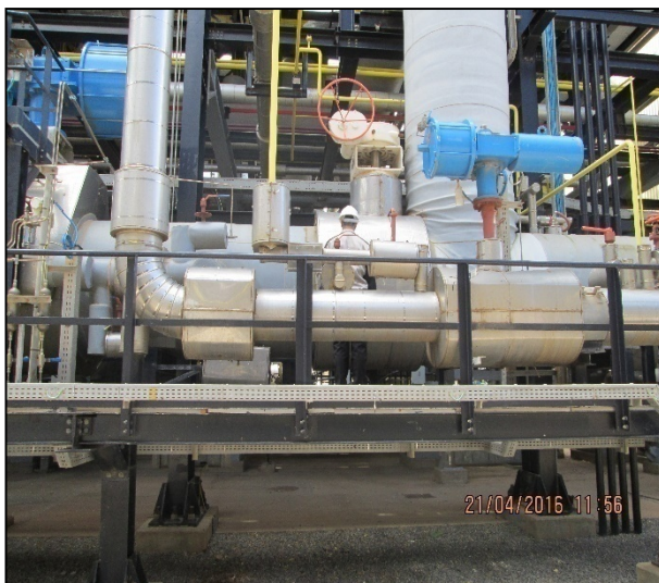
Figure 03 : Vannes inaccessibles
