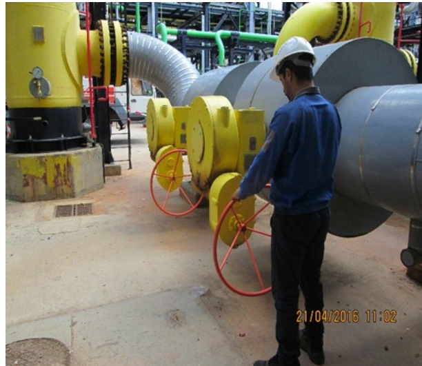
Figure 25.20 une vanne difficilement accessible
