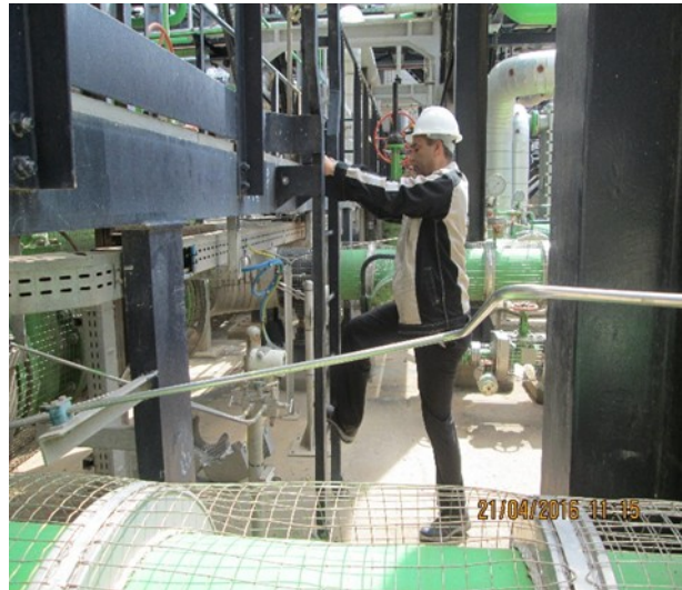
Figure 25.08 une mauvaise conception d'échelle
