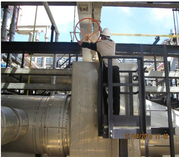
Figure 25.09 une plateforme de mauvaise conception
