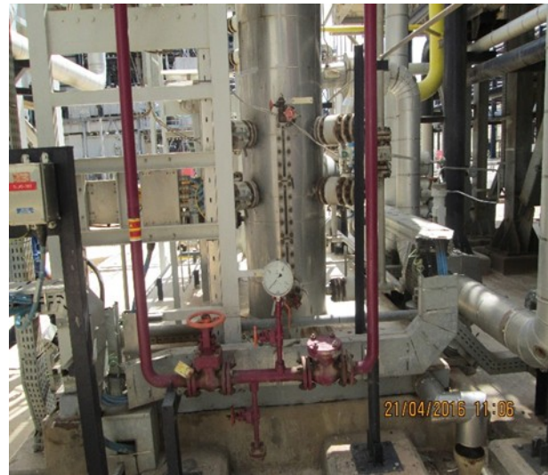
Figure 25.02 un baromètre bien positionnée/lisible
