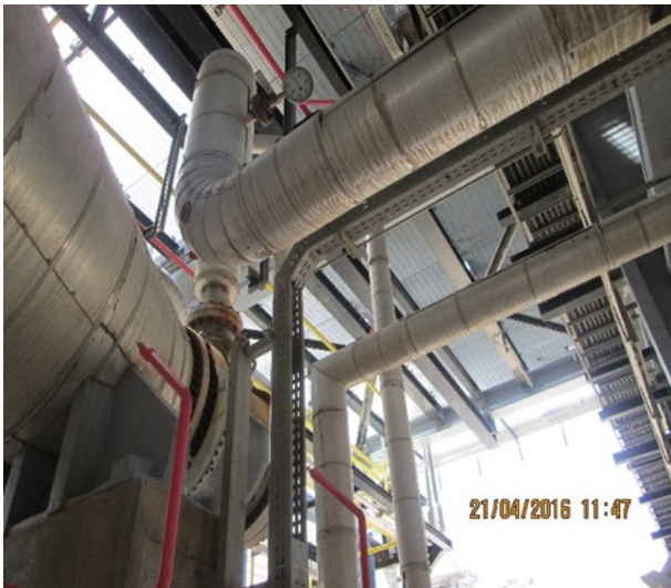
Figure 25.03 un baromètre mal positionné très haut
