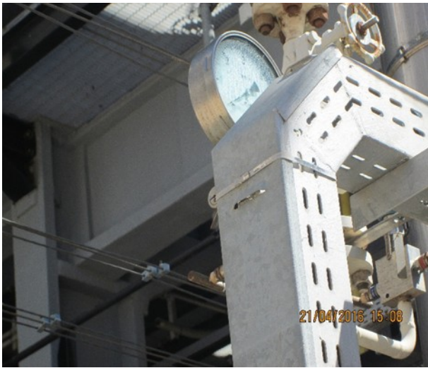
Figure 25.01 un baromètre mal positionnée/lisible
