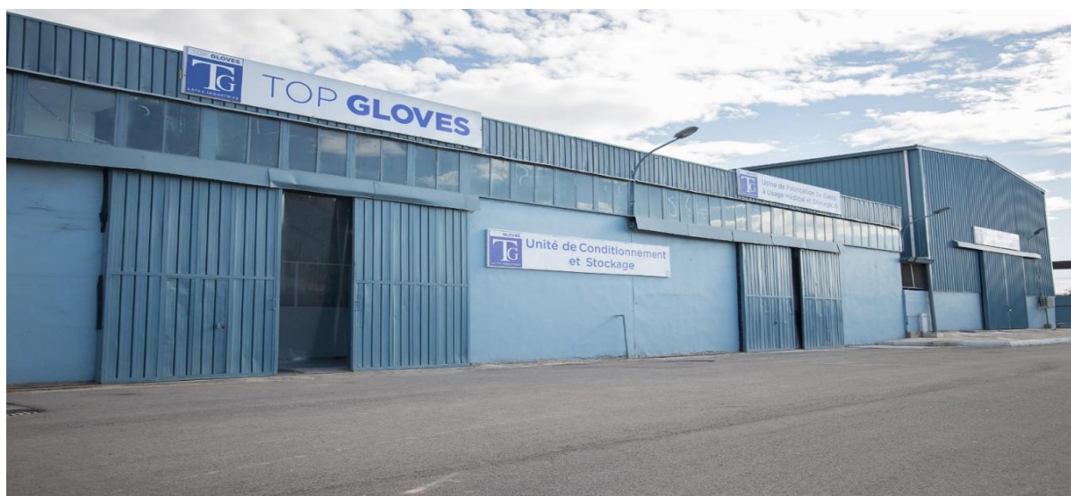
Figure1: Photo de l'usine TOP GLOVES [1]
