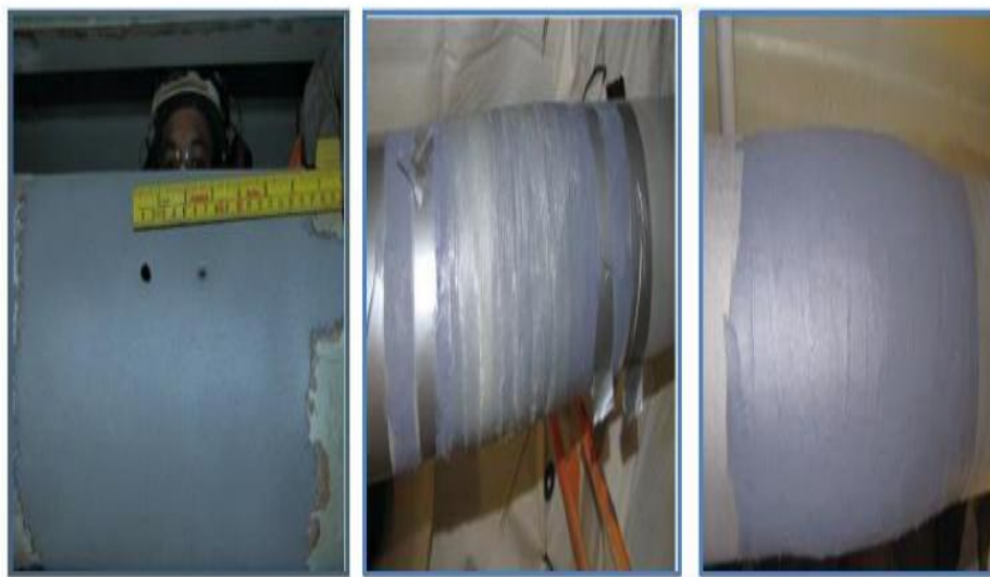
Figure[II-10] : Réparation par composites d'une pipe en acier
