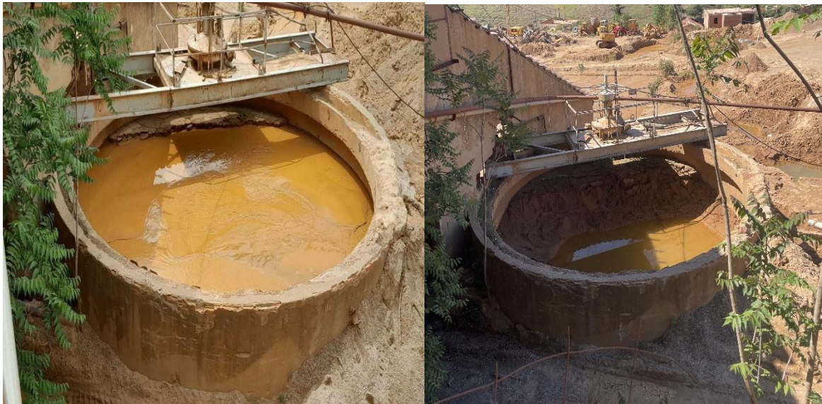
Figure 24 : bassin de décantation primaire
