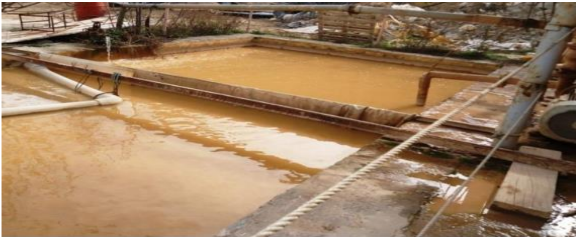
Figure 21 : Bassins de décantation de la poussière
