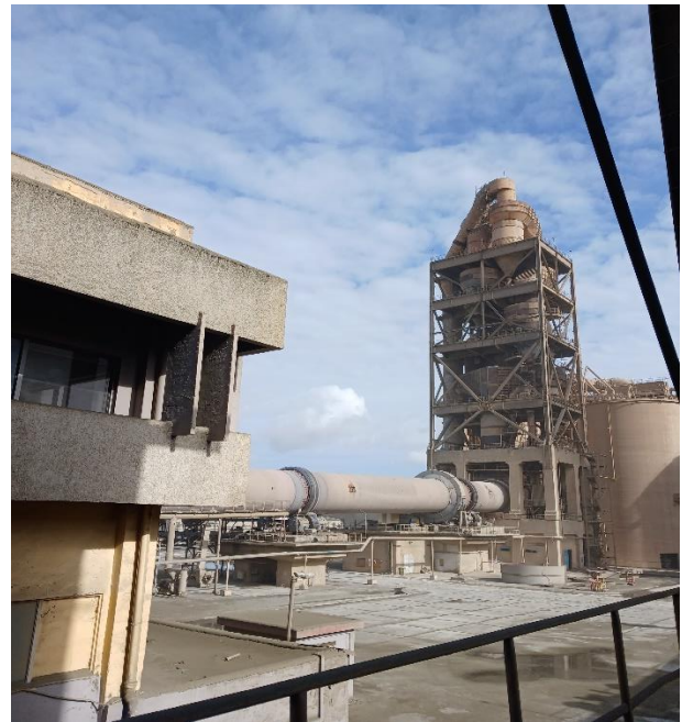
Figure 1.16: Tour de préchauffage (ligne 2).
