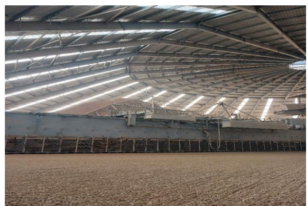
Figure 1.11: Un pont récupérateur (ligne 3).
