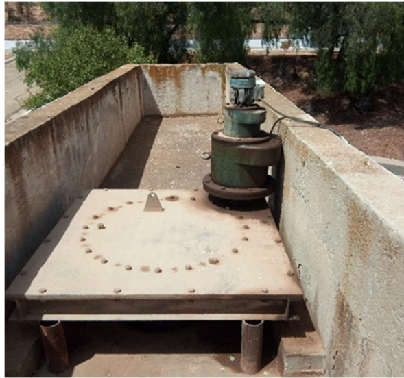
Figure II.27 : Motoréducteur d'épaississeur.
