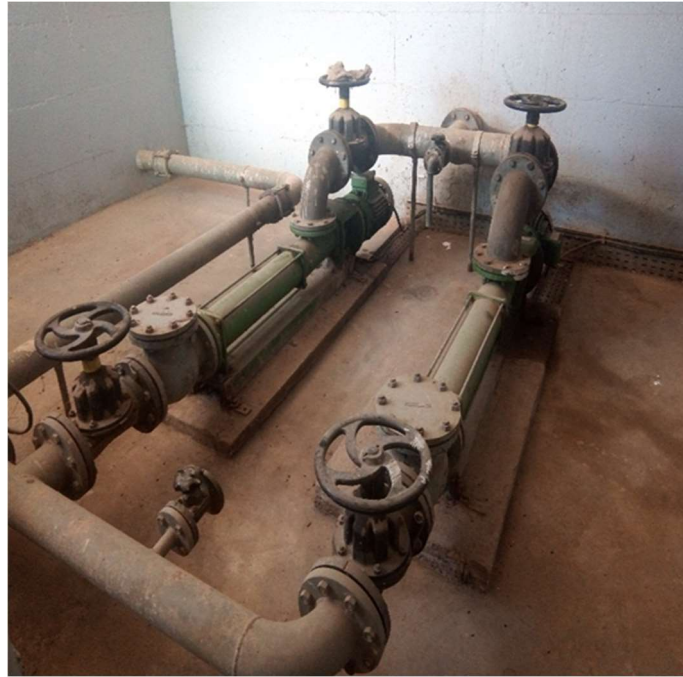
Figure II.20: Les pompes à vis.
