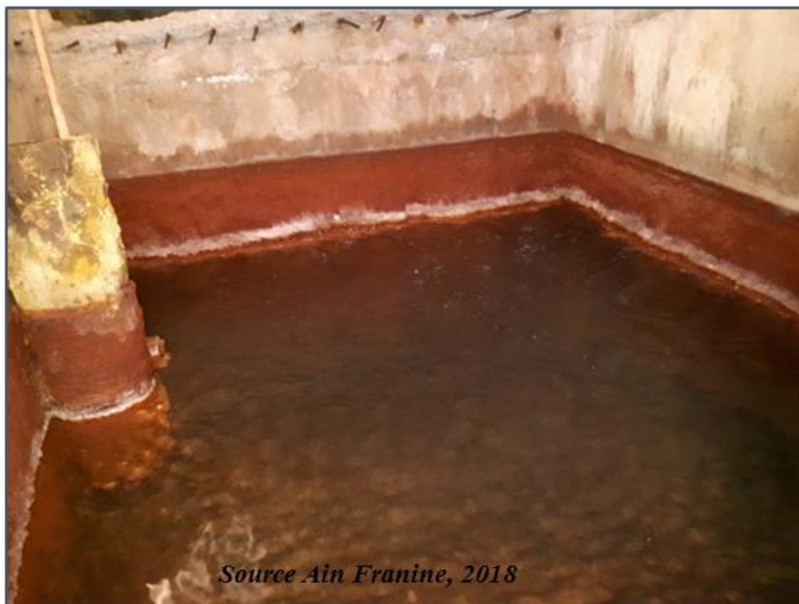
Photo 19 : L'intérieur du captage d'Ain Franine, observation en surface du dégagement de gaz, assez spectaculaire, coloration des parois du bassin carré de la source par les oxydes de fer, (Hadjou, 2018).
