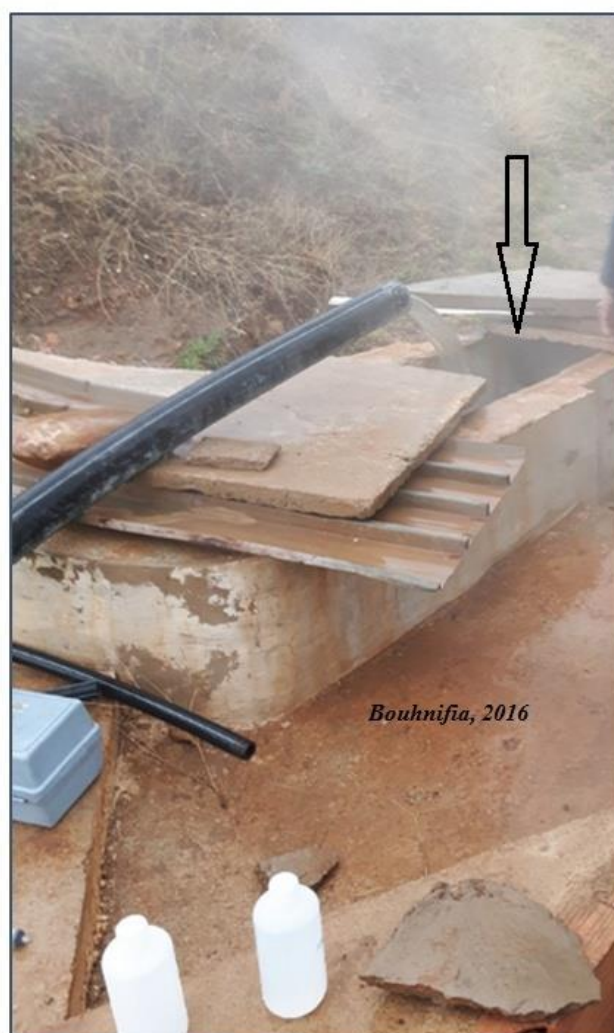
Photo25: Petit regard maçonné construit, au niveau des griffons, afin de canaliser les eaux thermales, et les diriger vers des canaux de transport.
