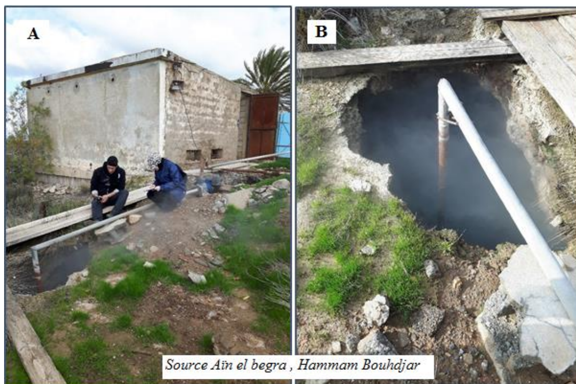
Photos 16(A et B) : Source Ain el Bagra, canalisations et réseau de transport vers la station du Hammam, (Hadjou, Décembre 2017).
