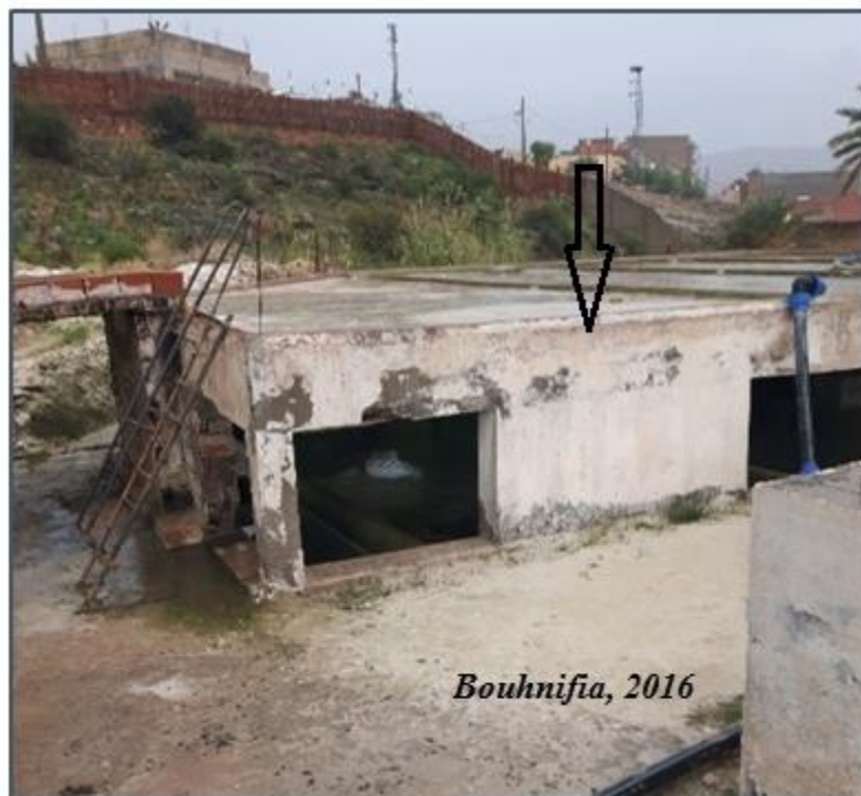
Photo 24: Bassins de stockage des eaux thermales. Unité d'emmagasiner de l'eau très chaude, prélevées dans les forages, pour refroidir sa température pendant la nuit, avant son usage en balnéothérapie.
