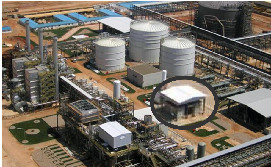
Figure 4. 1 zoom sur la cabine électrique sur le site de SORFERT (49)
