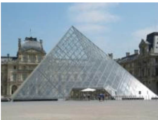
Figure 12 : Vitrage de la Pyramide du Louvre jointoyé avec un mastic silicone.
