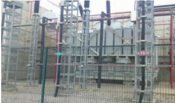
Figure 13. Transformateur principale
