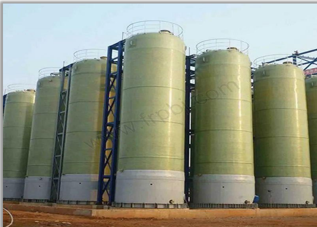
Figure II. 4 : Réservoirs en fibre de verre (avec résine alimentaire)
