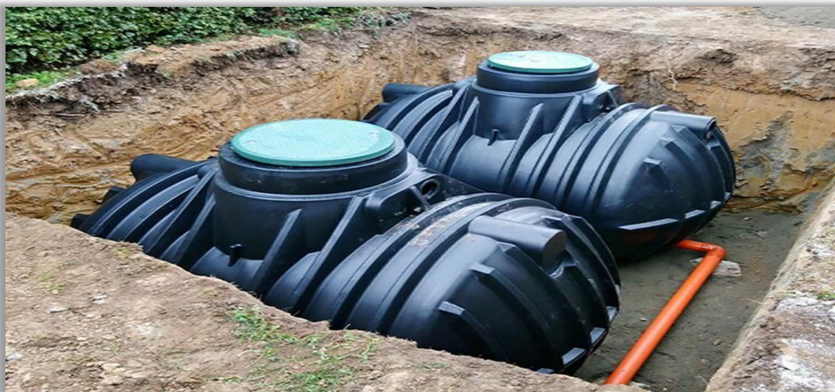
Figure II. 7 : Réservoirs enterrés
