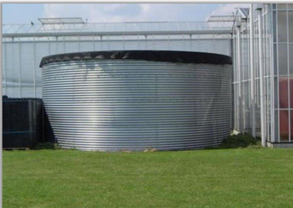
Figure II. 2 : Réservoirs en acier galvanisé
