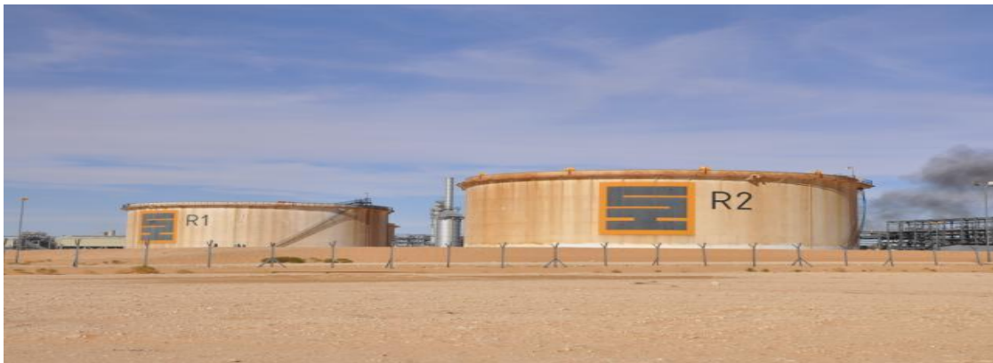
Figure 1.9 bac de stockage R1 et R2
