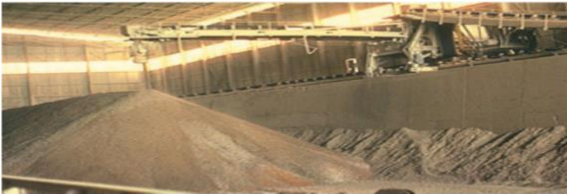
Figure 15: hall de pré homogénéisation
