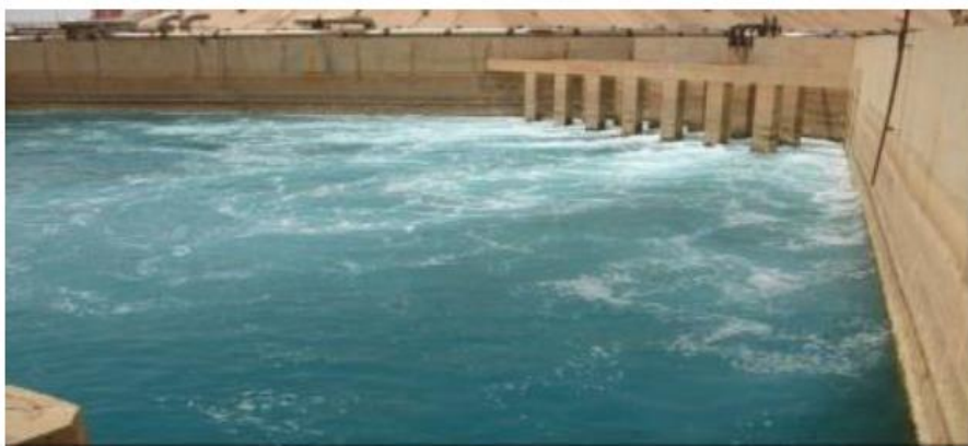
Fig. 1.6 : Bassin d'eau de mer (Ammari et Chlaoua, 2025).
