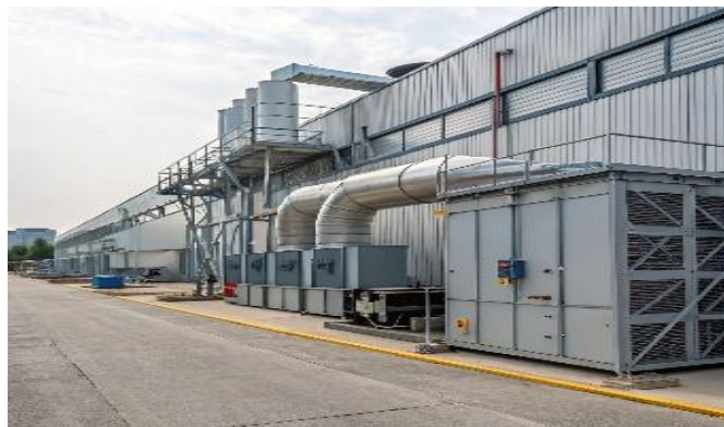
Figure 26 : ventilation générale des locaux
