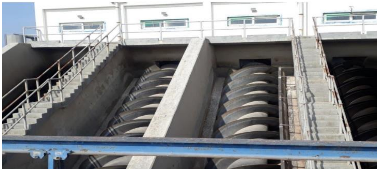
Figure III.8 : Vis d'Archimède.
