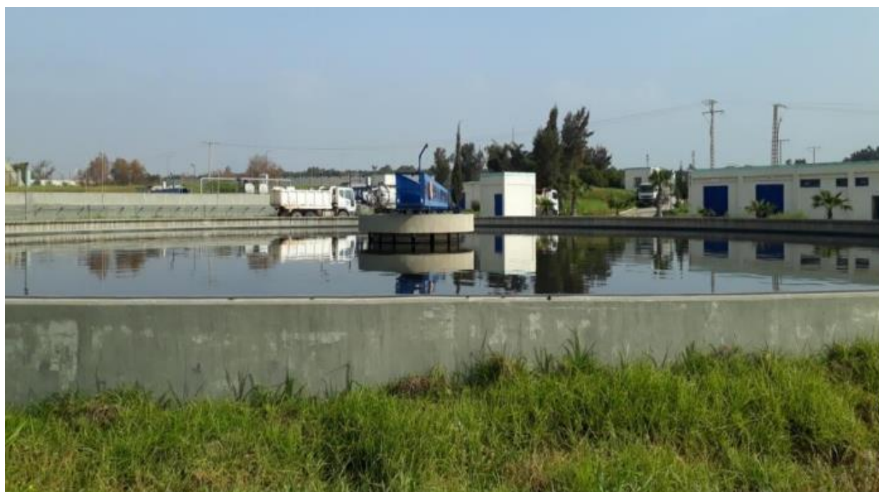
Figure III.4 : Décanteurs primaires
