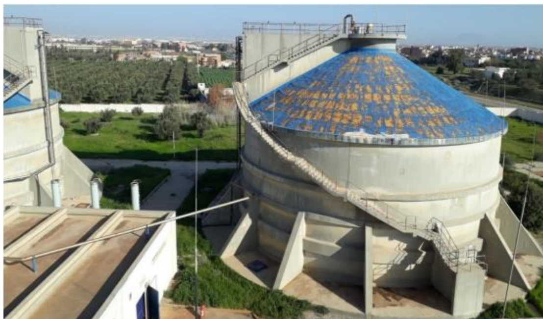
Figure III.11 : Digesteur anaérobie.
