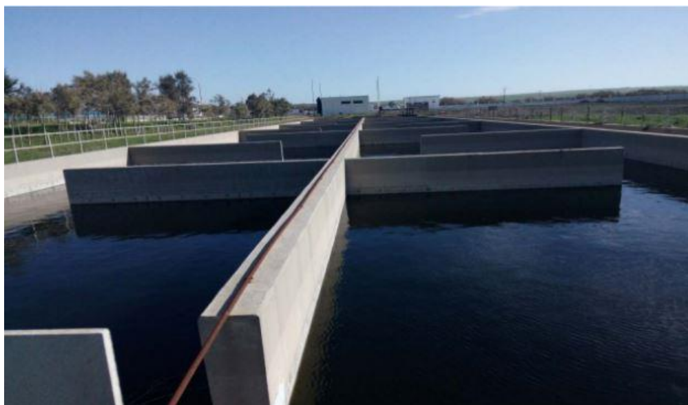
Figure III.7 : Bassin de désinfection.
