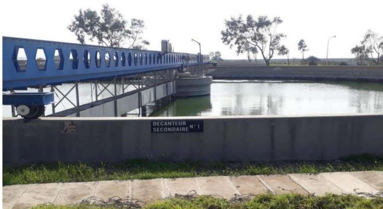
Figure III.6 : Décanteur secondaire.
