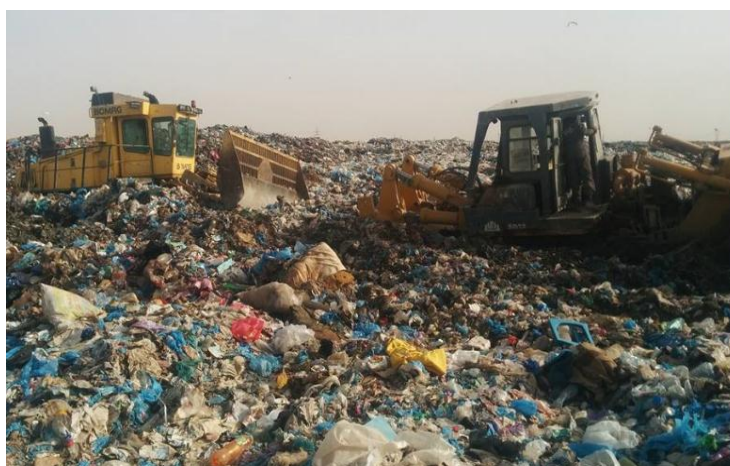
Figure 13:Étalement des déchets dans le casier
