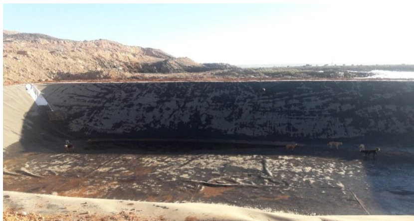
Figure 14: bassin de lixiviats
