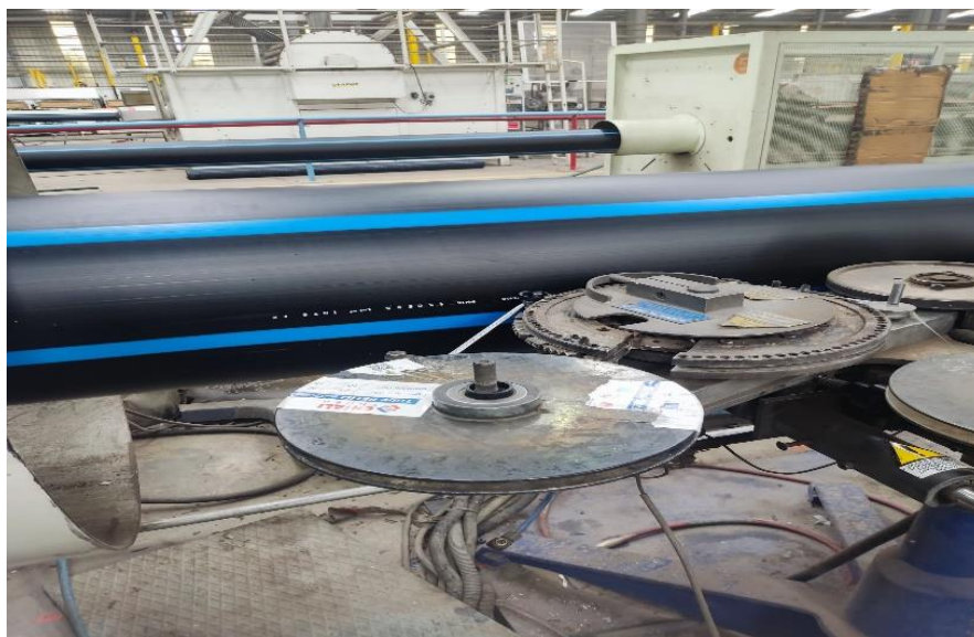
Figure 10 : marquage des tubes
