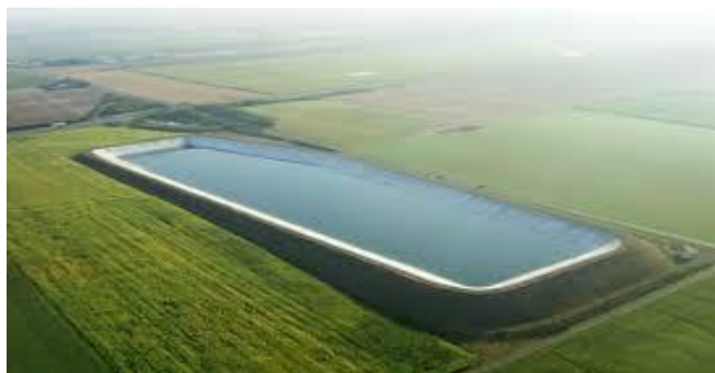
Figure 3.11 bassin de stockage d'eau
