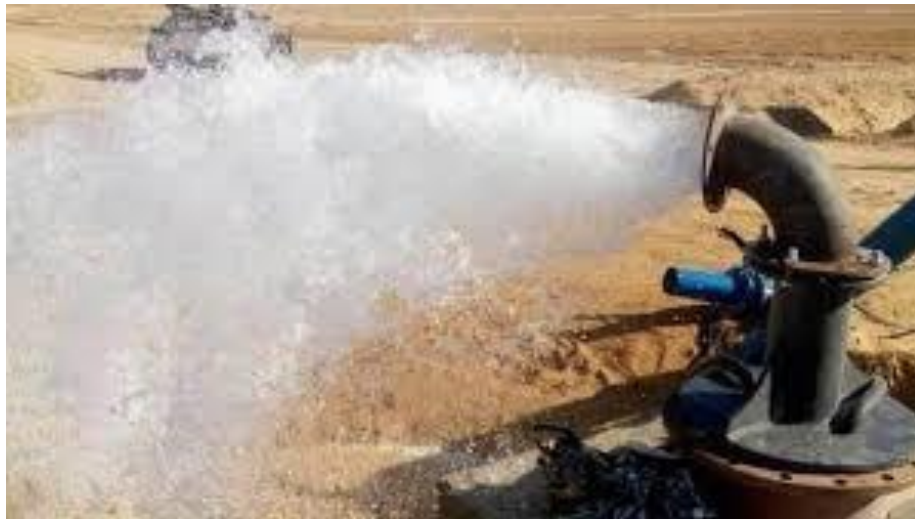
Figure 3.1 Sortie de Tuyau de Puits
